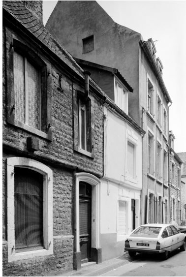
Façade sur voie.
