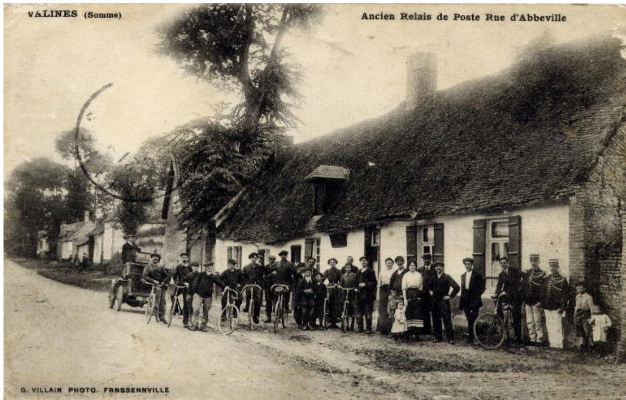
Ancien relais de poste de Valines, fin du 19e siècle (coll. part.).
