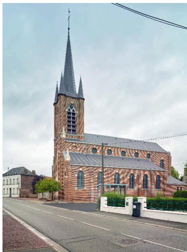
Vue générale de trois quarts depuis l'est. Phot. Pierre Thibaut IVR31_20155901633NUCA
