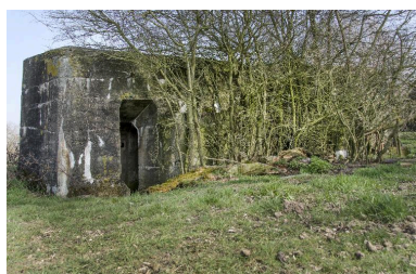
Élévation sud Phot. Jean-Marc Ramette IVR32_20175901082NUCA
