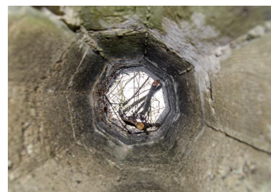
Poste de tir et de surveillance : Vue zénithale de la cheminée périscopique Phot. Jean-Marc Ramette IVR32_20175901081NUCA
