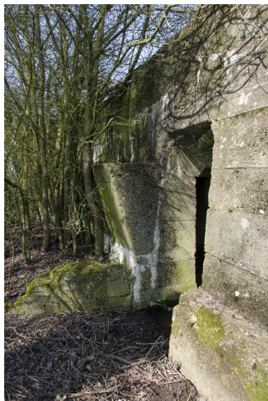
Profil taluté de l'élévation sud. A droite, l'entrée est, au centre, la banquette de tir Phot. Jean-Marc Ramette IVR32_20175901074NUCA
