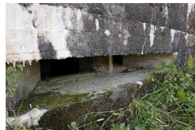
Elévation nord : Embrasures de tir et de surveillance Phot. Jean-Marc Ramette IVR31_20145904774NUCA
