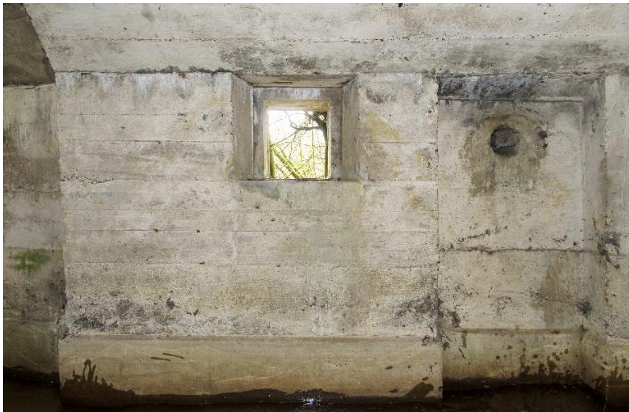
Baie dans l'élévation sud (pour escamoter la mitrailleuse ?) et conduit d'aération.
