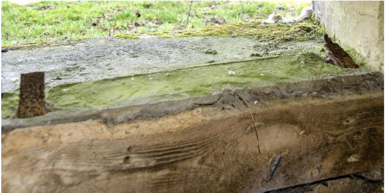
Vestiges du dispositif d'occultation de l'embrasure de tir et de surveillance
