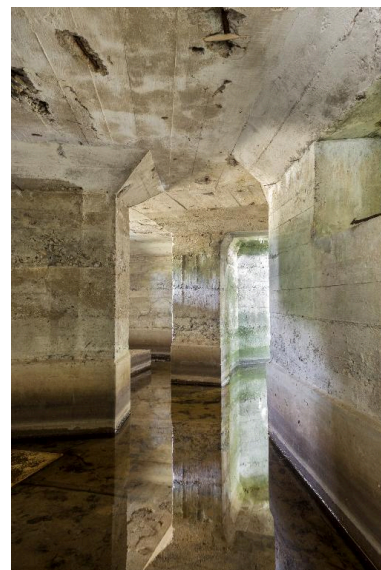
Vue intérieure vers l'entrée est Phot. Jean-Marc Ramette IVR31_20145904772NUCA
