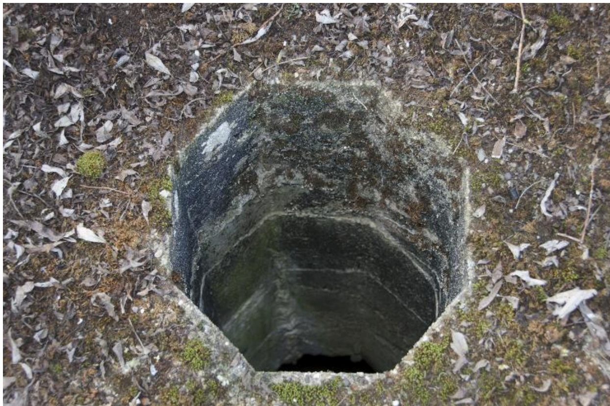
Couvrement. Sortie de la cheminée du périscope
