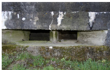
Elévation nord : Embrasures de tir et de surveillance Phot. Jean-Marc Ramette IVR32_20175901076NUCA
