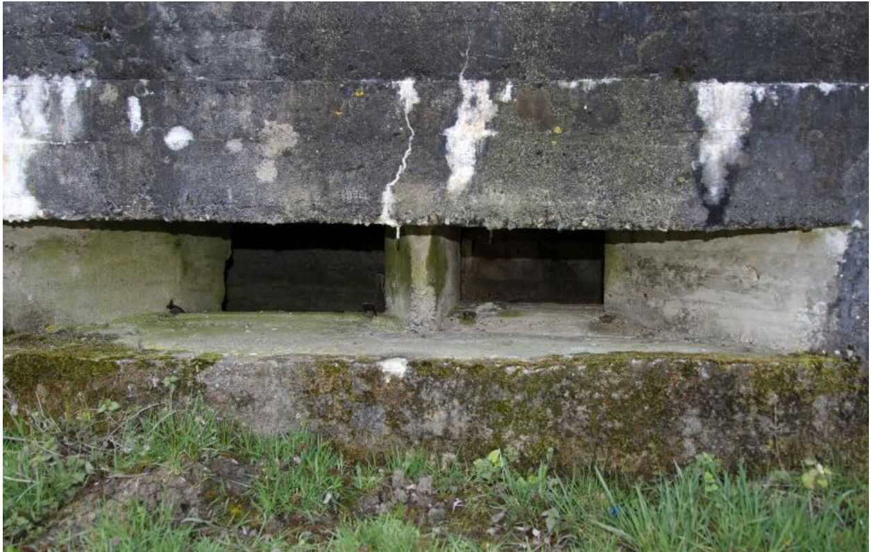
Élévation nord : Embrasures de tir et de surveillance
