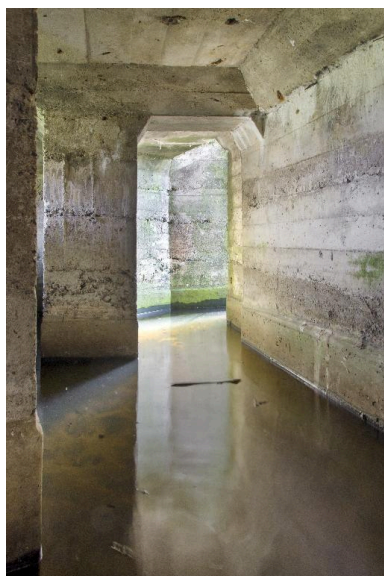
Vue intérieure vers l'entrée est Phot. Jean-Marc Ramette IVR32_20175901088NUCA
