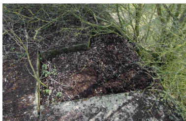
Cuve a mitrailleuse sur le couverture Phot. Jean-Marc Ramette IVR32_20175901083NUCA
