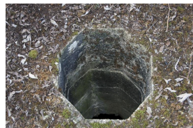
Couverture. Sortie de la cheminée du périscopes Phot. Jean-Marc Ramette IVR32_20175901084NUCA
