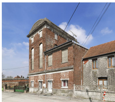
La brasserie, vue de trois-quarts. Phot. Thierry Lefébure IVR22_20158000162NUC2A
