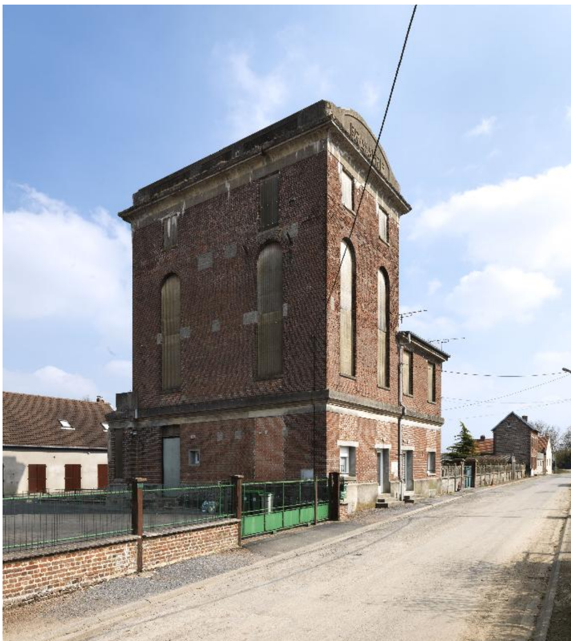
Vue d'ensemble côté nord.
