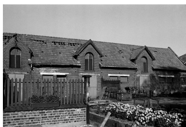
Etable à chevaux en 1990. Phot. Francis Dubuc IVR22_19908001281Z
