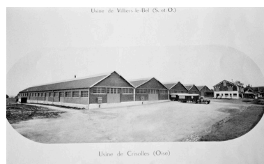
Vue d'ensemble de l'usine de roulements avec la succession des magasins et des ateliers et, au fond, le logement du directeur et les bureaux, 1965 (AP).
