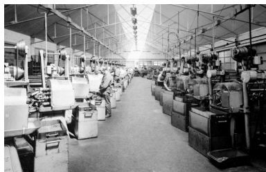
Intérieur de l'atelier de décolletage, vers 1970 (AP). Phot. Fournier Bertrand (reproduction) IVR22_20006000438ZB
