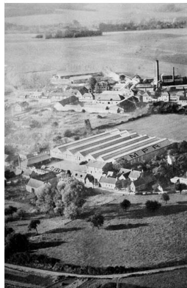
Vue aérienne de l'usine de roulements MPR, avant 1970 (AP). Phot. Fournier Bertrand (reproduction) IVR22_20006000447ZB
