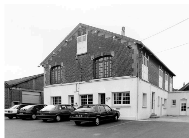
Bureaux et logement du directeur à l'étage avec date portée de 1947, au sommet du pignon. Phot. Benoît Dufournier IVR22_19936001658Z
