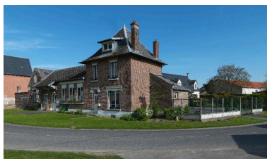
Vue générale, depuis le nord- est. La clôture délimitait le jardin de l'instituteur. Phot. Marie-Laure Monnehay-Vulliet IVR22_20148000358NUC2A
