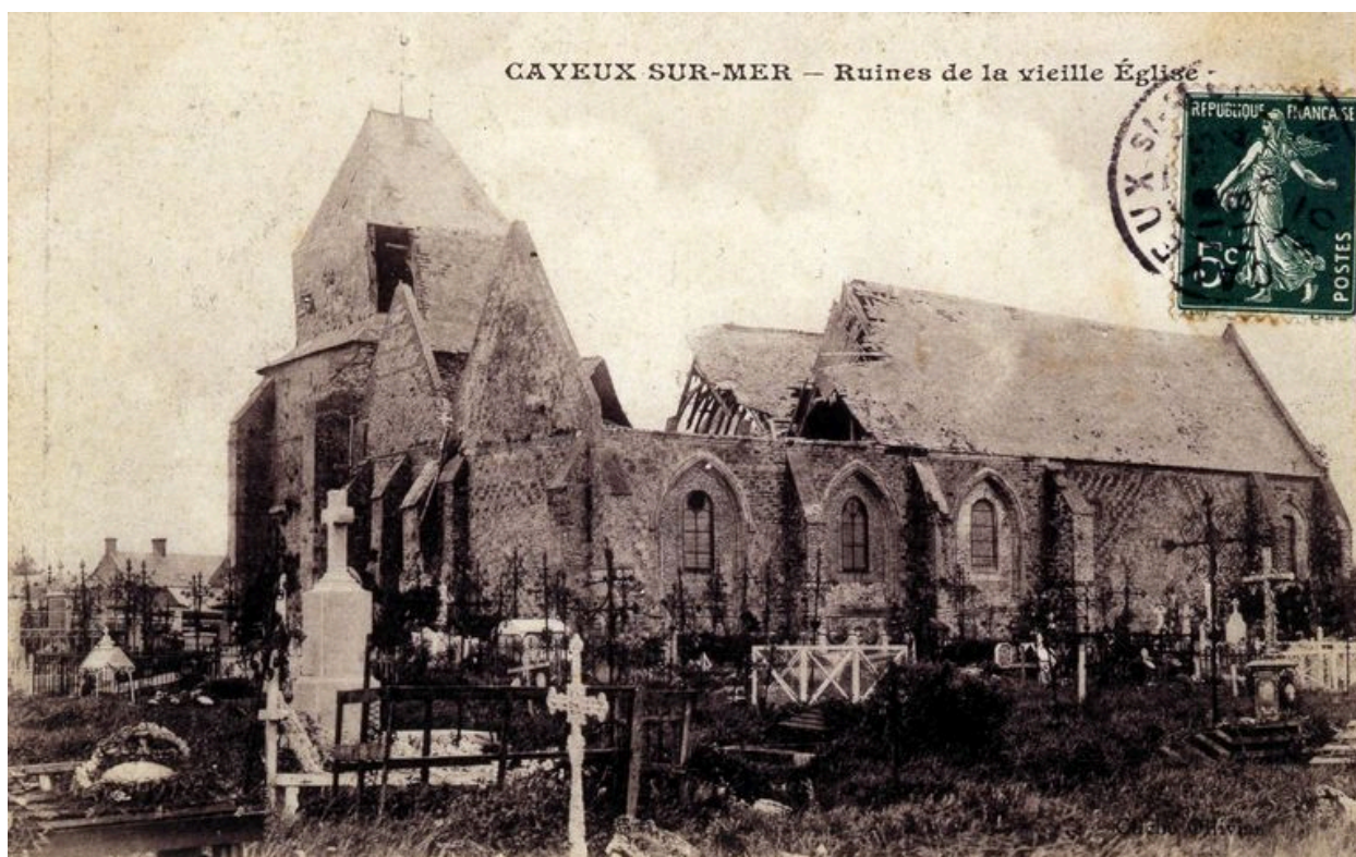
L'ancienne église paroissiale de Cayeux-sur-Mer en cours de dégradation, carte postale, 1er quart 20e siècle (coll. part.).
