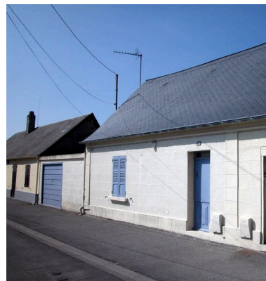
Maison, 29 rue d'Enfer, portant la plaque de l'entrepreneur cayolais Bellet. Phot. Elisabeth Justome IVR22_20048001420NUCA
