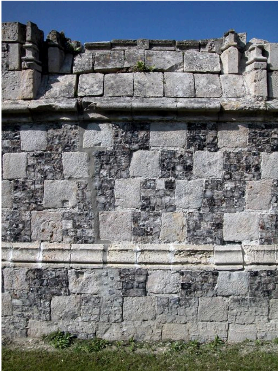
Détail de l'appareil mixte (craie, silex) de l'ancienne église paroissiale en ruines.
