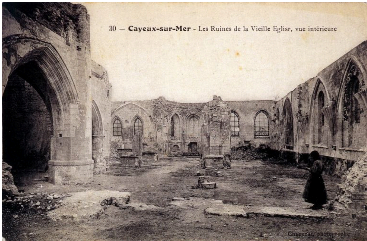
Vue intérieure des ruines de l'ancienne église paroissiale de Cayeux-sur-Mer (détruite), carte postale, 1er quart 20e siècle (coll. part.).
