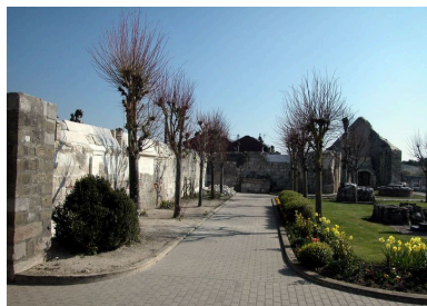
Vue de l'ancien bas-côté nord de l'église paroissiale en ruines. Phot. Elisabeth Justome IVR22_20048001412NUCA
