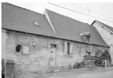
Elévation antérieure. Phot. Jean-Michel Perrin IVR22_19856000771X
