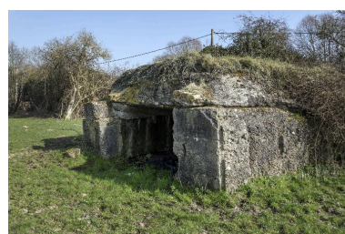
Sortie de la chambre de tir, vers l'est Phot. Jean-Marc Ramette IVR32_20165900995NUC
