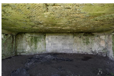
Vue intérieure de la chambre de tir, vers le sud-est. Phot. Jean-Marc Ramette IVR32_20165900996NUC
