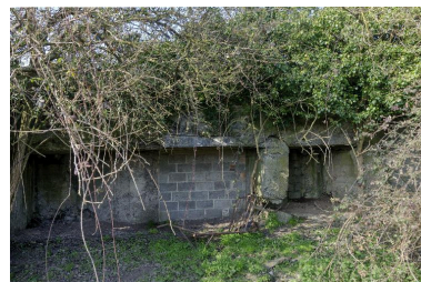
Élévation sud-est. L'accès à la chambre de tir (au centre) et les accès latéraux (magasin à munition, abri du personnel) ont été murés Phot. Jean-Marc Ramette IVR32_20165900998NUC
