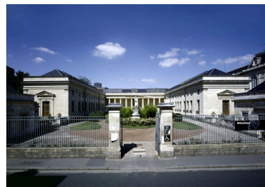
Vue générale. Phot. Thierry Lefébure IVR22_20038000767PA
