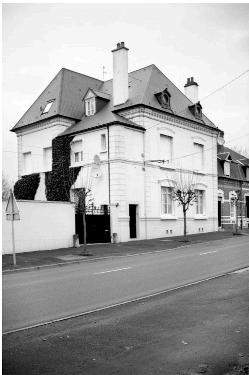
Vue de l'ancien logis patronal situé au n° 724, rue André-Godin, restauré, ou reconstruit à l'identique, après la première guerre mondiale.
