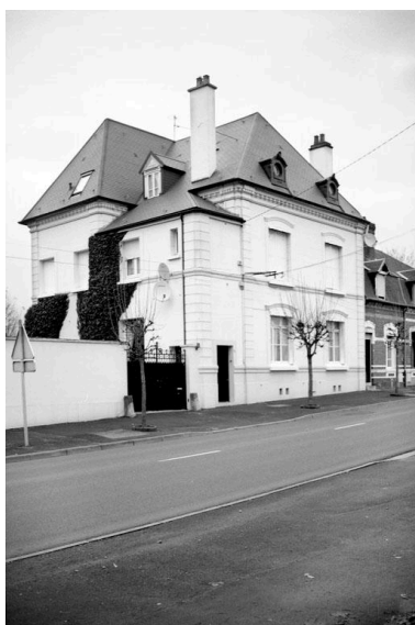
Vue de l'ancien logis patronal situé au n° 724, rue André-Godin, restauré, ou reconstruit à l'identique, après la première guerre mondiale.
