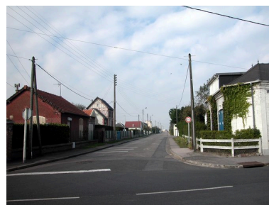
Entrée du lotissement, vue depuis la rue du Maréchal-Foch. Phot. Elisabeth Justome IVR22_20058003099NUCA
