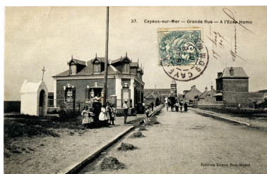
Entrée du lotissement, carte postale, 1er quart 20e siècle (coll. part.). Phot. Monnehay-Vulliet Marie-Laure IVR22_20058000401XAB
