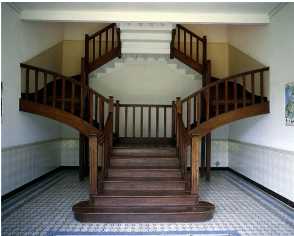
Vue de l'escalier intérieur en charpente.
