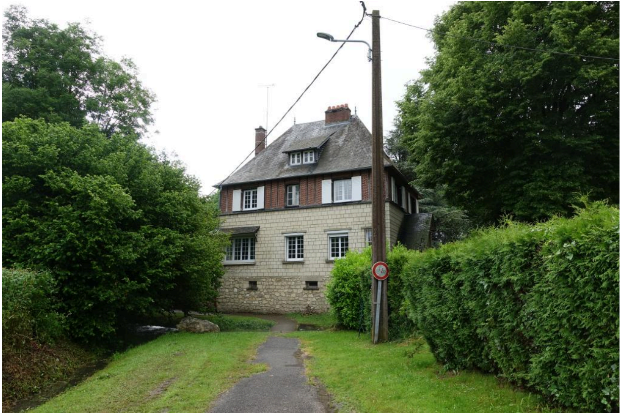
Logis vu depuis le nord-ouest.
