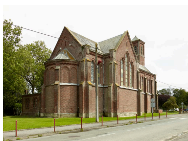
Vue générale depuis le nord-est. Phot. Delphine Volto-Jourdan IVR32_20215900142NUCA
