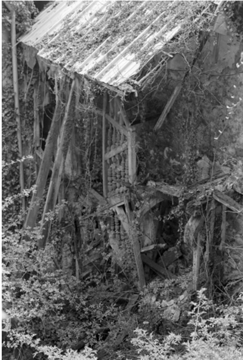
L'escalier extérieur sur la cour, depuis le jardin en terrasse.
