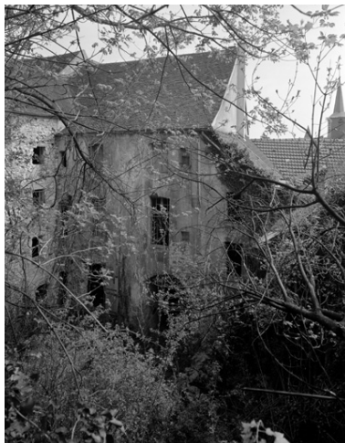
La face arrière, depuis le jardin en terrasse. Phot. Thierry Lefébure IVR22_19940200321V
