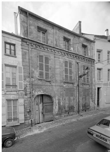
Vue de la façade sur la rue. Phot. Thierry Lefébure IVR22_19940201123P
