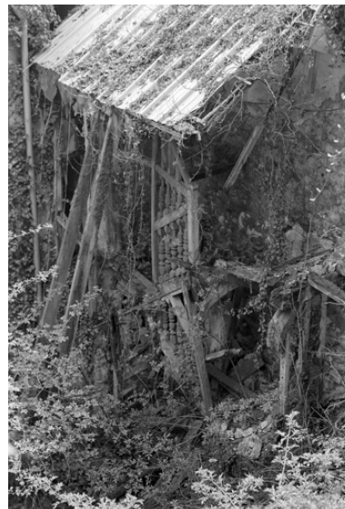
L'escalier extérieur sur la cour, depuis le jardin en terrasse. Phot. Thierry Lefébure IVR22_19940200327X
