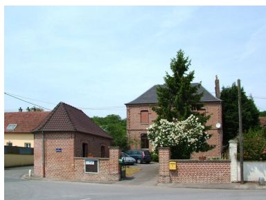
Vue générale depuis la rue. Phot. Frédéric Fournis IVR22_20108001374NUCA
