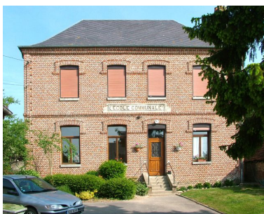
Vue du bâtiment principal en fond de cour. Phot. Frédéric Fournis IVR22_20108001366NUCA
