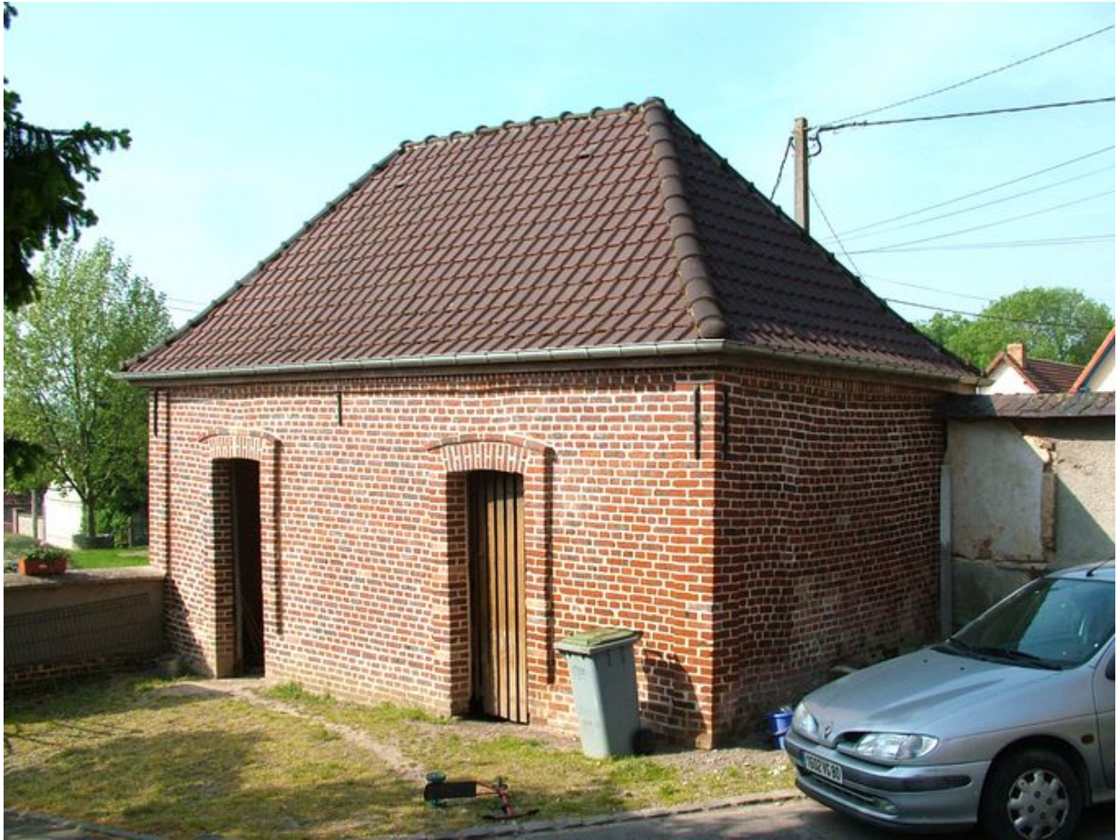
Vue du bâtiment annexe en bordure de cour.
