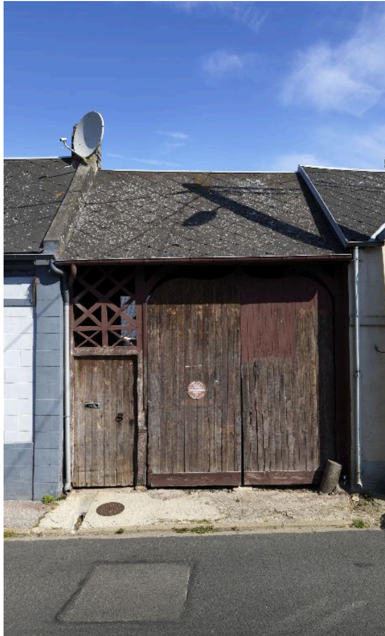
Porte charretière et porte piétonnière de la ferme située au n°17 de la rue Maurice-Thorez.
