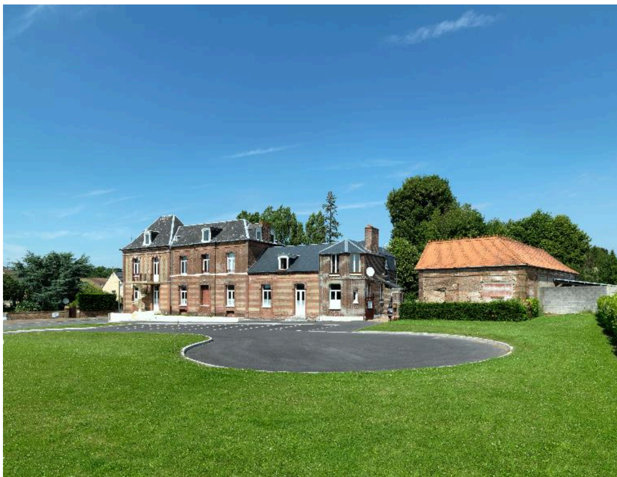
Ancien logement patronal Caqueret.
