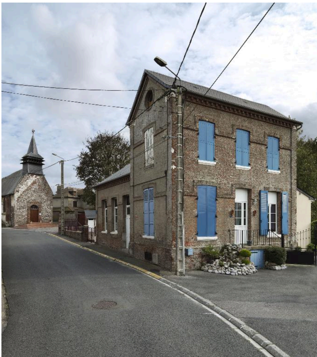
Ancienne école des filles, allée des Ecoliers.
