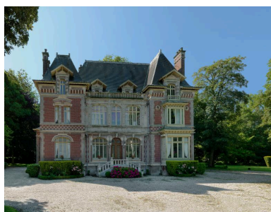
Ancienne demeure de l'industriel Camille Buiret. Phot. Thierry Lefébure IVR22_20148000438NUC2A
