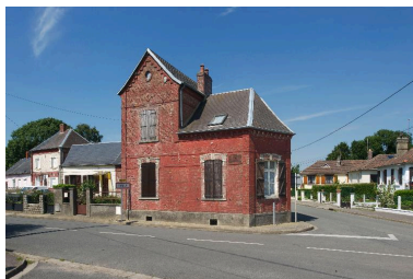
Ancien café situé au n°19 de la rue Charles-Acoulon. Phot. Thierry Lefébure IVR22_20148000426NUC2A
