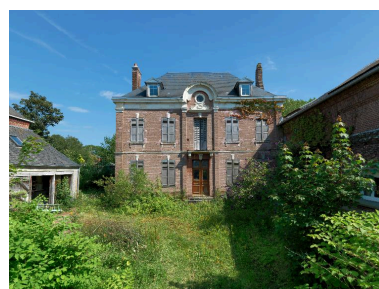
Ancien logement patronal Beauvisage. Phot. Thierry Lefébure IVR22_20148000434NUC2A
