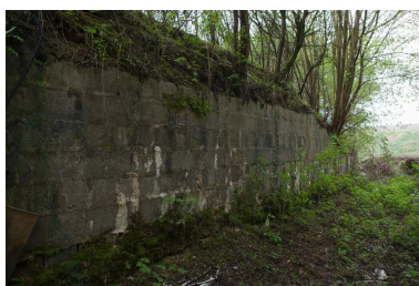
Elévation latérale. Phot. Pierre Thibaut IVR31_20126201642NUCA
