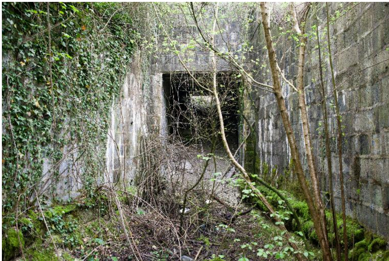
Vue des tunnels. Murs de protection.
