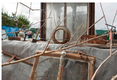
Vue partielle. Phot. Hubert Bouvet IVR31_20125900178NUC4A
