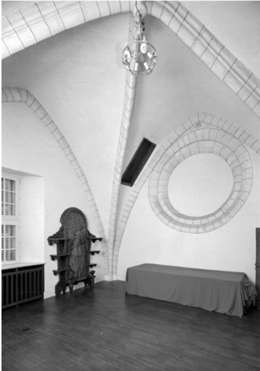
Le voûtement de la première travée.
