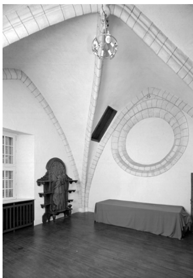
Le voûtement de la première travée.
