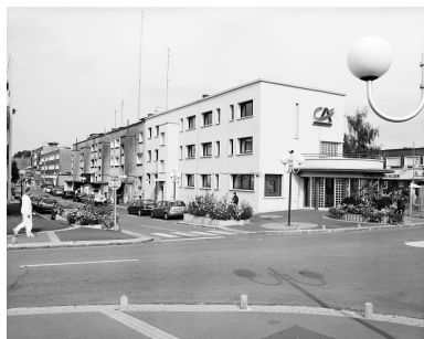
Vue générale de l'îlot M, l'élévation postérieure, rue de la porte de France. Phot. Thierry Petitberghien IVR31_20025902327X
