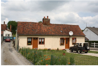
Vue générale. Phot. Bertrand Fournier IVR22_20098005132NUCA
