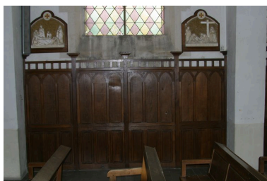
Vue des lambris de demi- revêtements de la nef. Phot. Inès Guérin IVR22_20050200874NUCA
