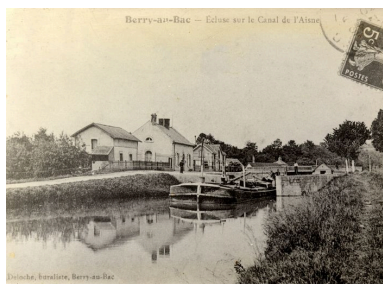
Vue ancienne des constructions près de l'écluse de l'Aisne (coll. part). Phot. Inès Guérin IVR22_20030202605NUCAB
