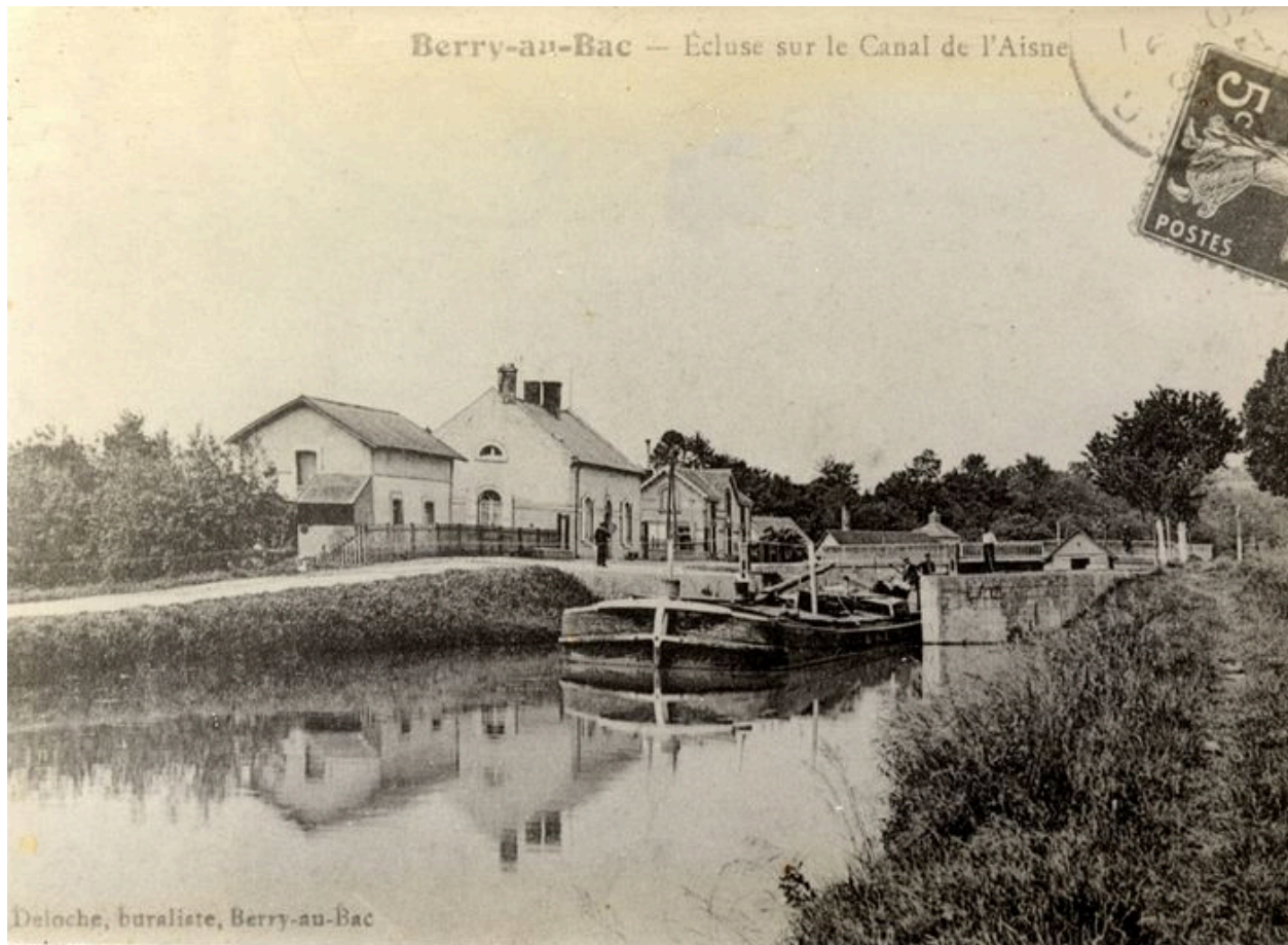
Vue ancienne des constructions près de l'écluse de l'Aisne (coll. part).
