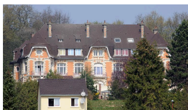
Vue de face du château. Phot. Thierry Lefébure IVR22_20128000134NUC2A
