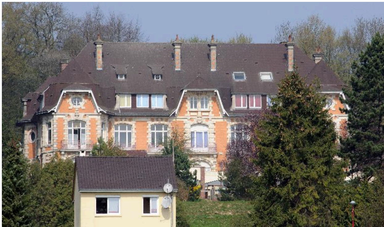
Vue de face du château.
