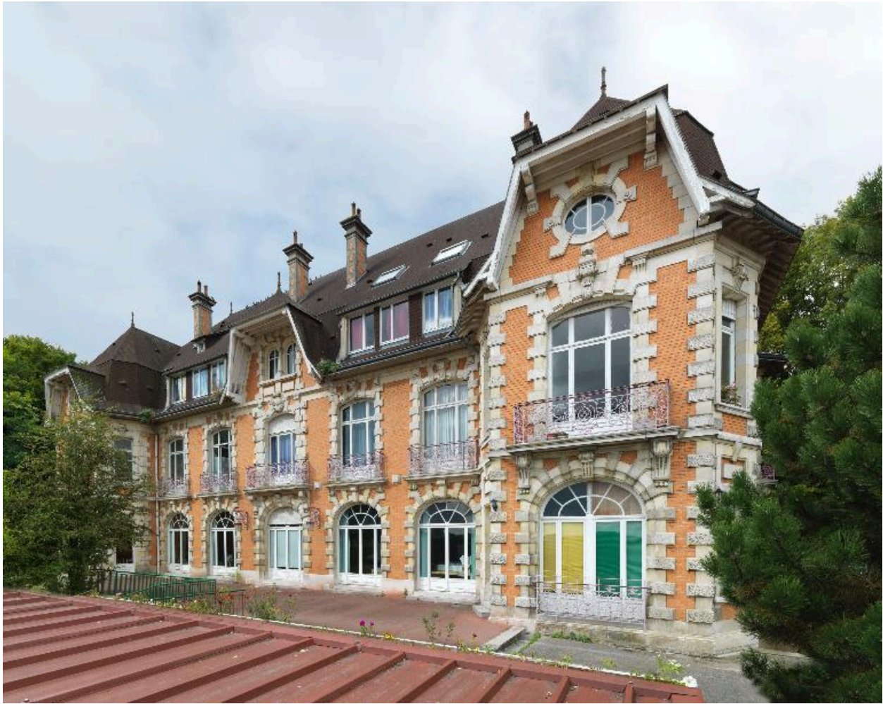
Vue de trois-quarts du château.
