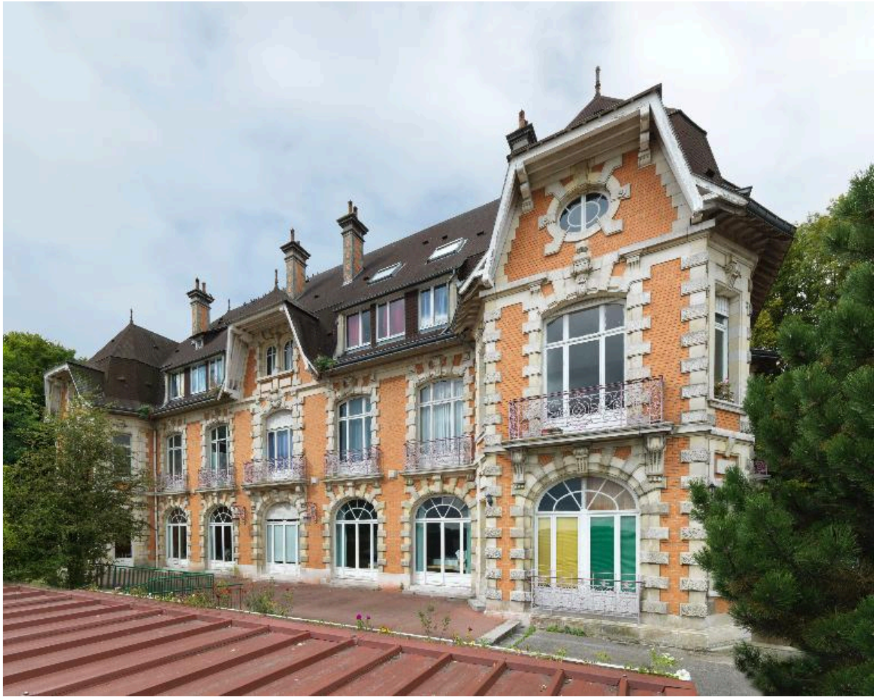
Vue de trois-quarts du château.
