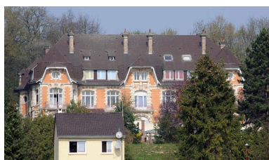
Vue de face du château. Phot. Thierry Lefébure IVR22_20128000134NUC2A
