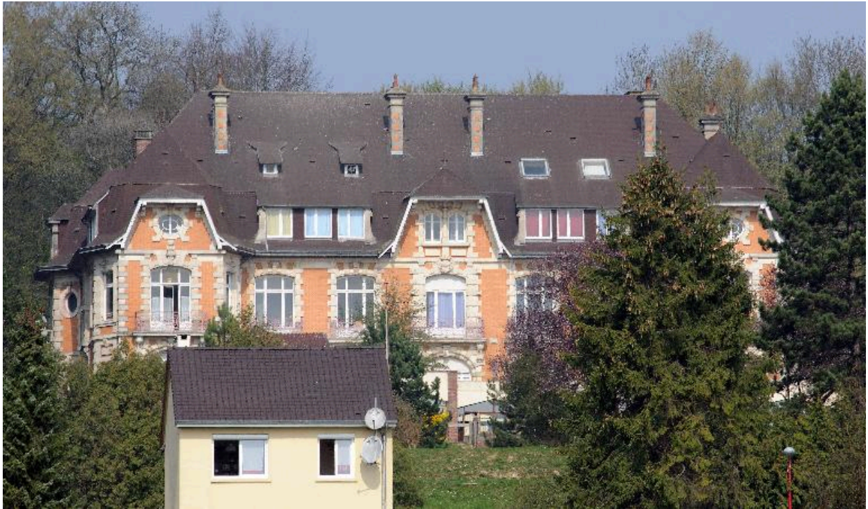
Vue de face du château.
