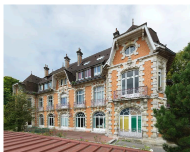
Vue de trois-quarts du château. Phot. Thierry Lefébure IVR22_20128000851NUC2AQ
