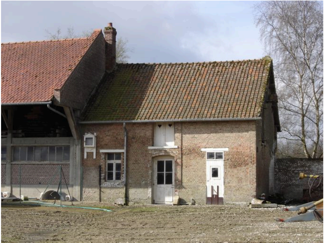
Vue du bâtiment sud.
