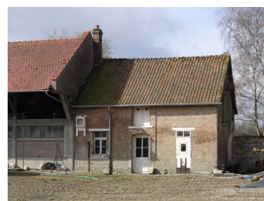
Vue du bâtiment sud.
