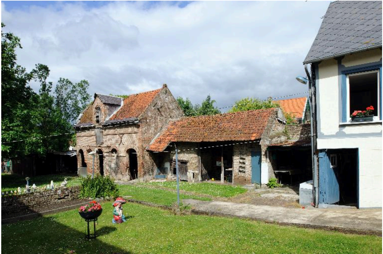
Etable et pigeonier, façade sur cour.
