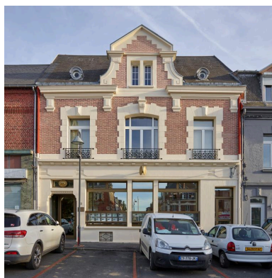
Ancienne banque Adam, n°3 place Faidherbe. Façade principale depuis la place. Construite en 1929 par l'architecte parisien Bonnard. (AD Pas-de-Calais, 10R9/115, dossier n°1955). Phot. Hubert Bouvet IVR32_20196200476NUC4A
