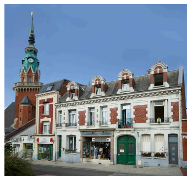
Maison de commerce, n°14 et 16 place Faidherbe. Ancienne menuiserie-quicaillerie-habitation construite pour M. Béhal par Eugène Bidard en 1922. (AD Pas-de-Calais, 10R9/6, dossier n°86). Phot. Hubert Bouvet IVR32_20196200448NUC4A
