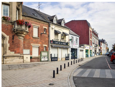
Place Faidherbe, côté nord vu depuis la rue de Péronne. Vue actuelle. Phot. Hubert Bouvet IVR32_20196200451NUC4A
