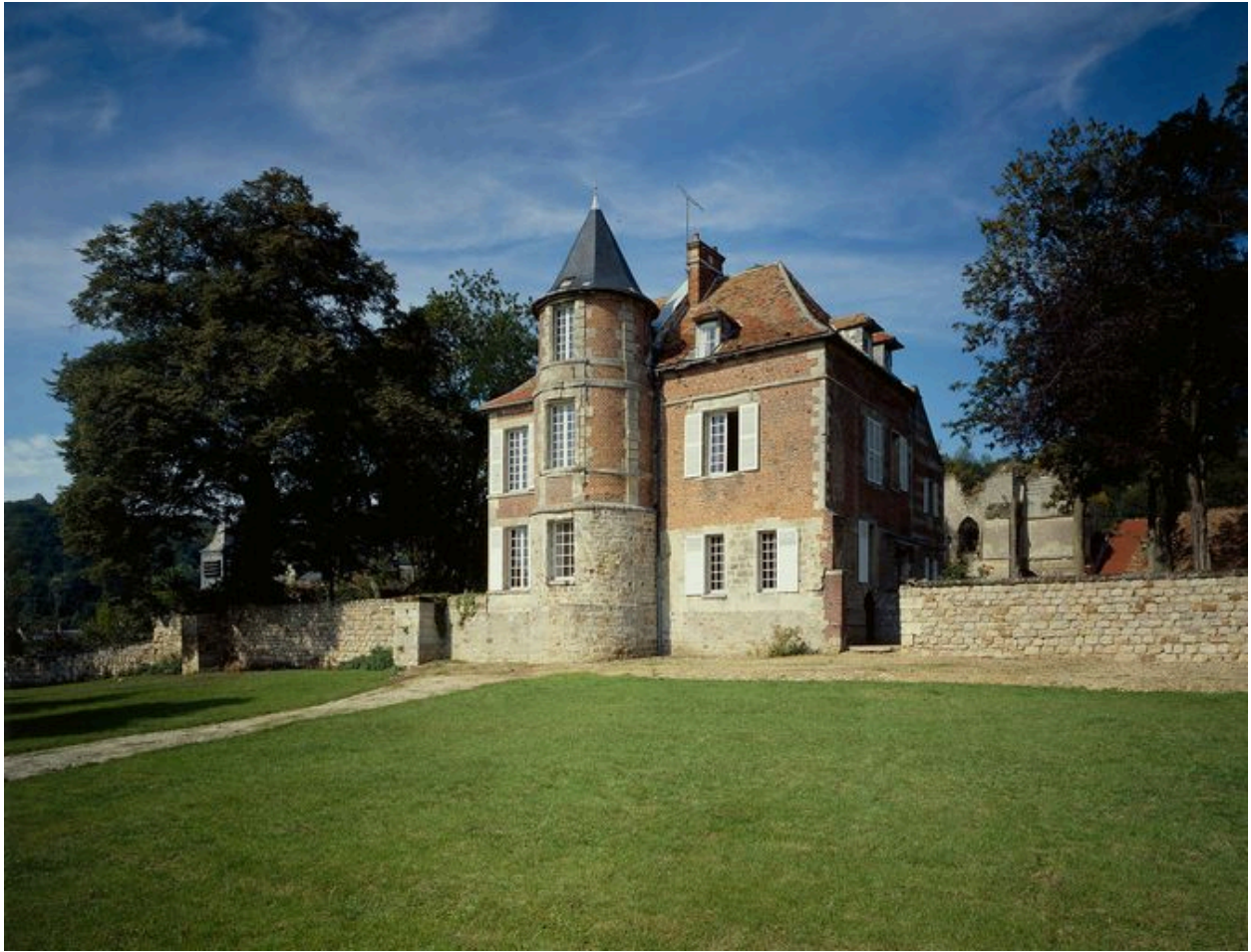
Logis. Vue générale.
