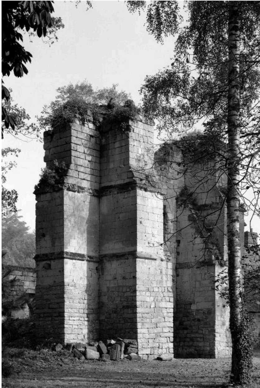
Ouvrage d'entrée. Détail des contreforts.
