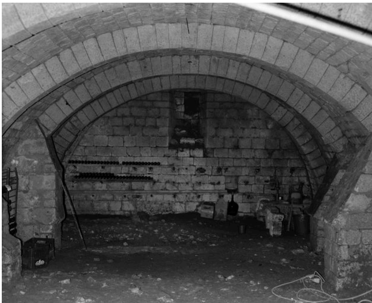
Premier étage de sous-sol.
