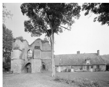
Ouvrage d'entrée. Elévation postérieure.
