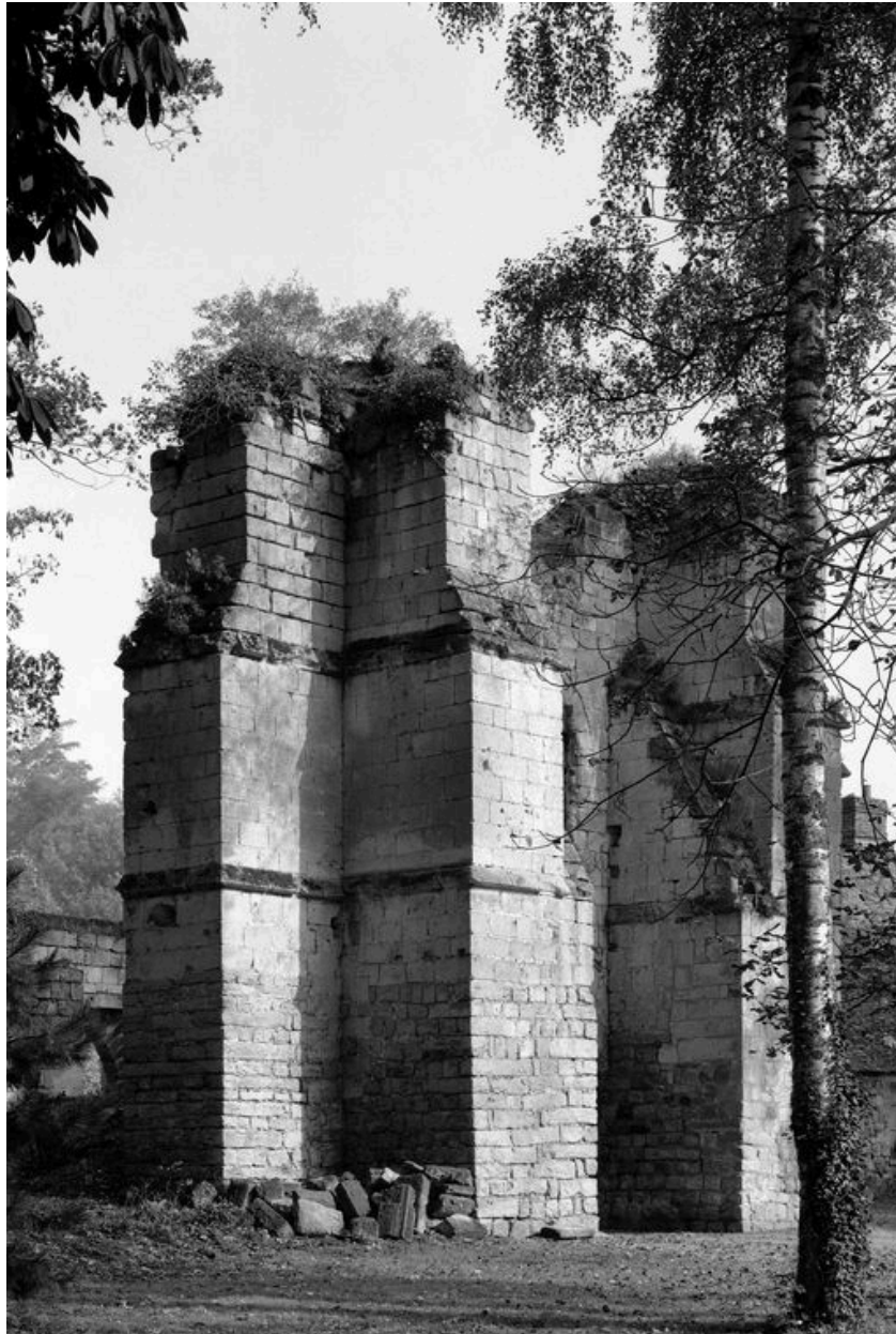
Ouvrage d'entrée. Détail des contreforts.
