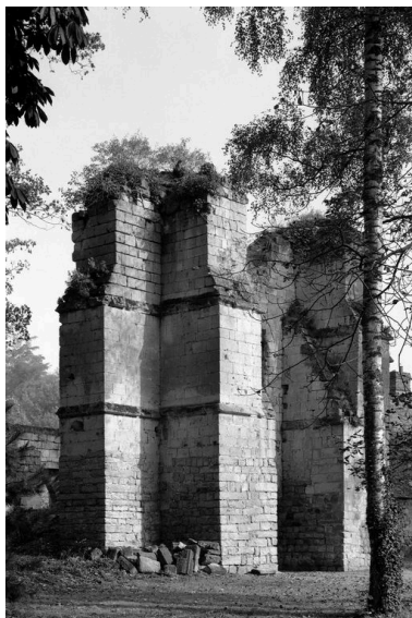
Ouvrage d'entrée. Détail des contreforts. Phot. Jean-Michel Perrin IVR22_19846001238X
