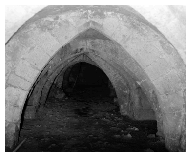
Deuxième étage de sous-sol. Phot. Jean-Michel Perrin IVR22_19846001248X
