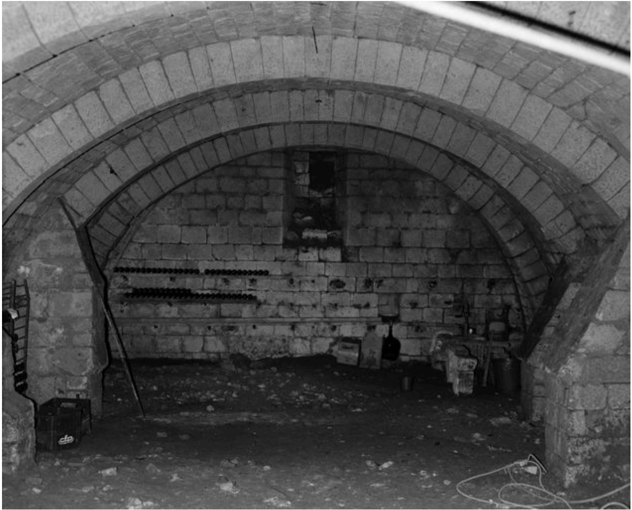
Premier étage de sous-sol.
