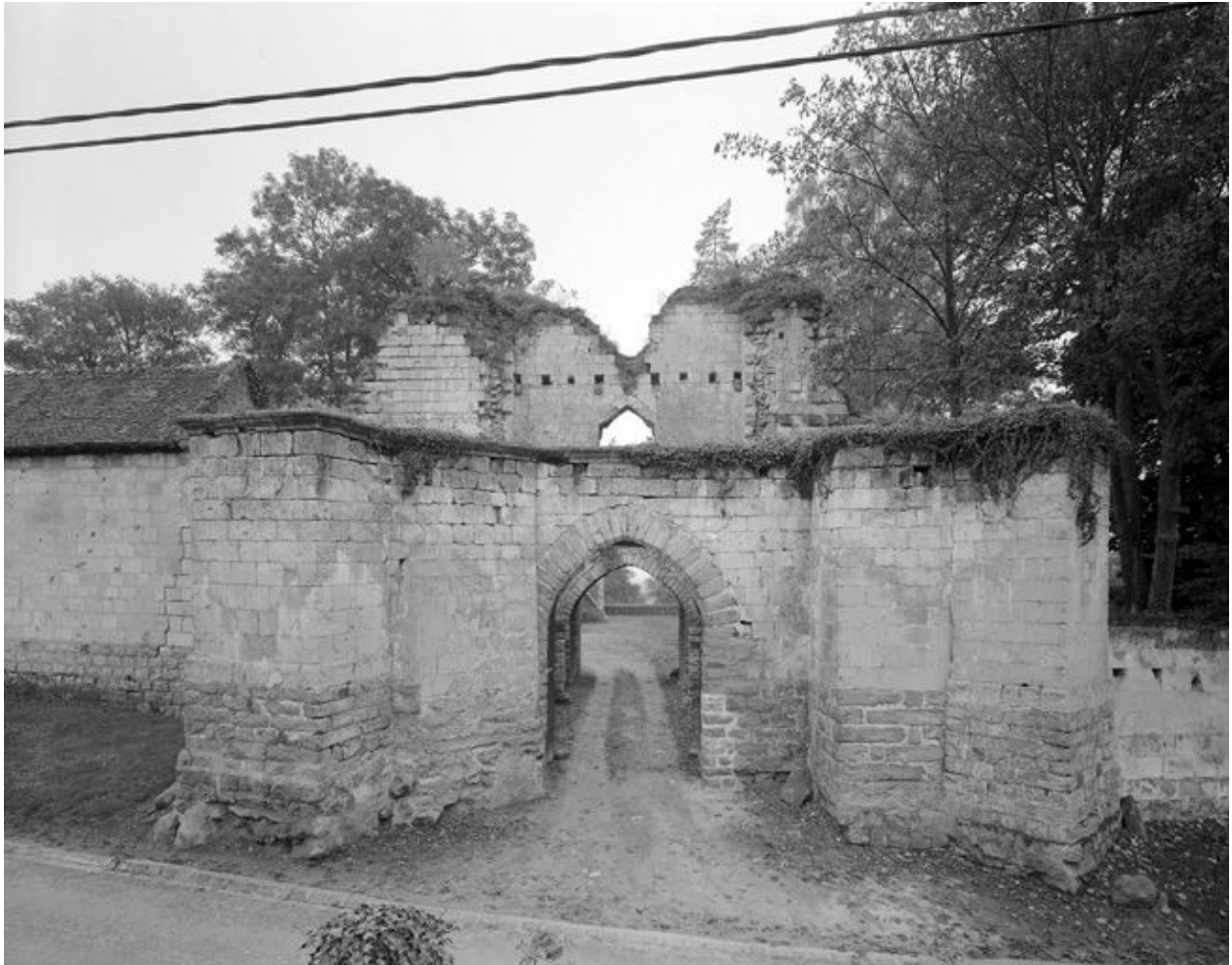
Ouvrage d'entrée. Elévation antérieure.
