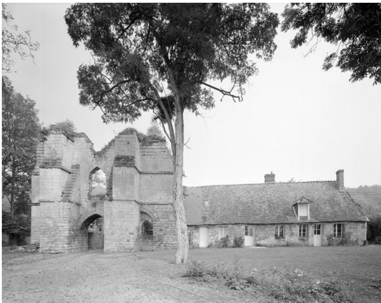
Ouvrage d'entrée. Elévation postérieure.
