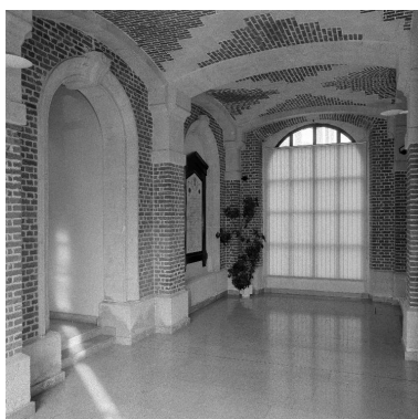
Vue intérieure : ancien passage traversant vers la cour. Phot. Thierry Lefébure IVR22_19978001005X
