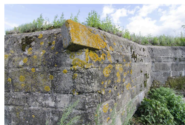
Pierre angulaire saillante sur la tourelle nord, probablement une des fixations de la bâche de camouflage Phot. Jean-Marc Ramette IVR31_20145905104NUCA
