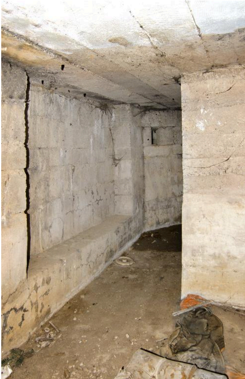
Vue intérieure, passage entre les deux salles, vers le sud
