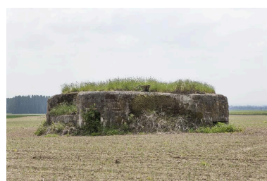
Vue de trois-quarts, vers le sud-ouest Phot. Jean-Marc Ramette IVR31_20145905126NUCA
