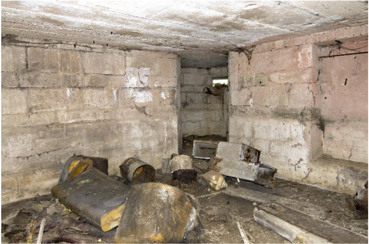
vue intérieure de la salle nord. En face l'entrée de la tourelle nord
