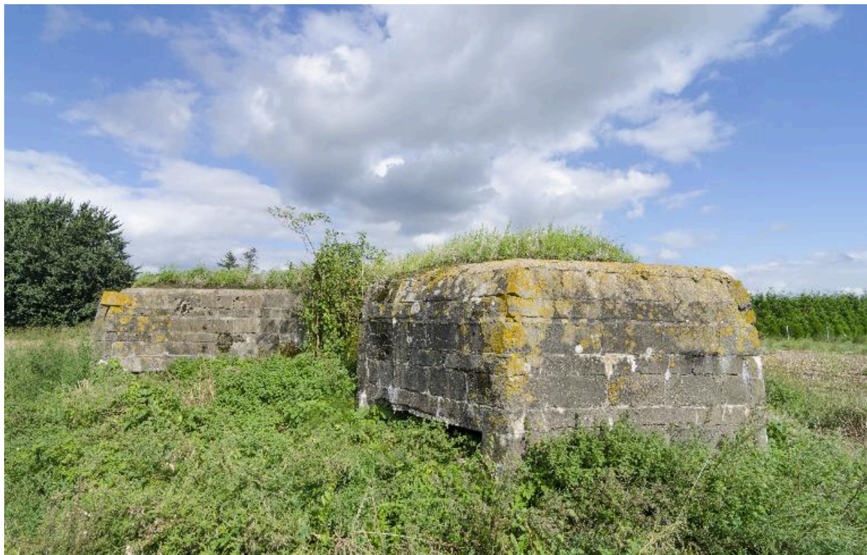
Vue de trois-quarts vers le nord-est
