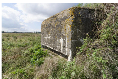
Vue vers le nord-ouest. Embrasure de tir de la tourelle sud Phot. Jean-Marc Ramette IVR31_20145905115NUCA
