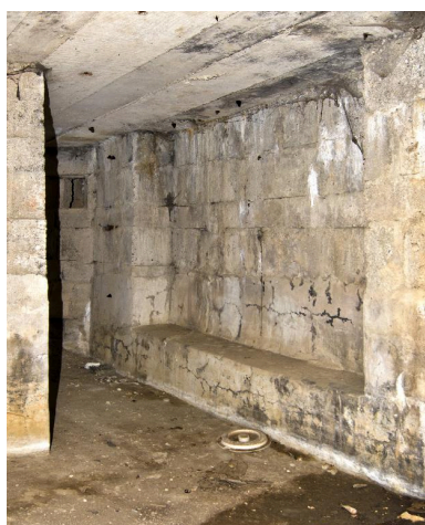
Vue intérieure. Passage entre les deux salles et grande niche, à droite Phot. Jean-Marc Ramette IVR31_20145905084NUCA
