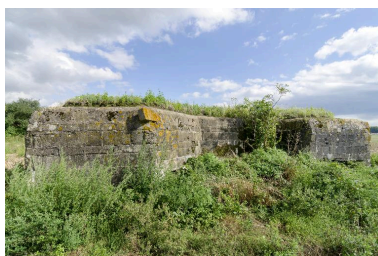
Élévation ouest, vers le sud- est (au grand angulaire) Phot. Jean-Marc Ramette IVR31_20145905120NUCA
