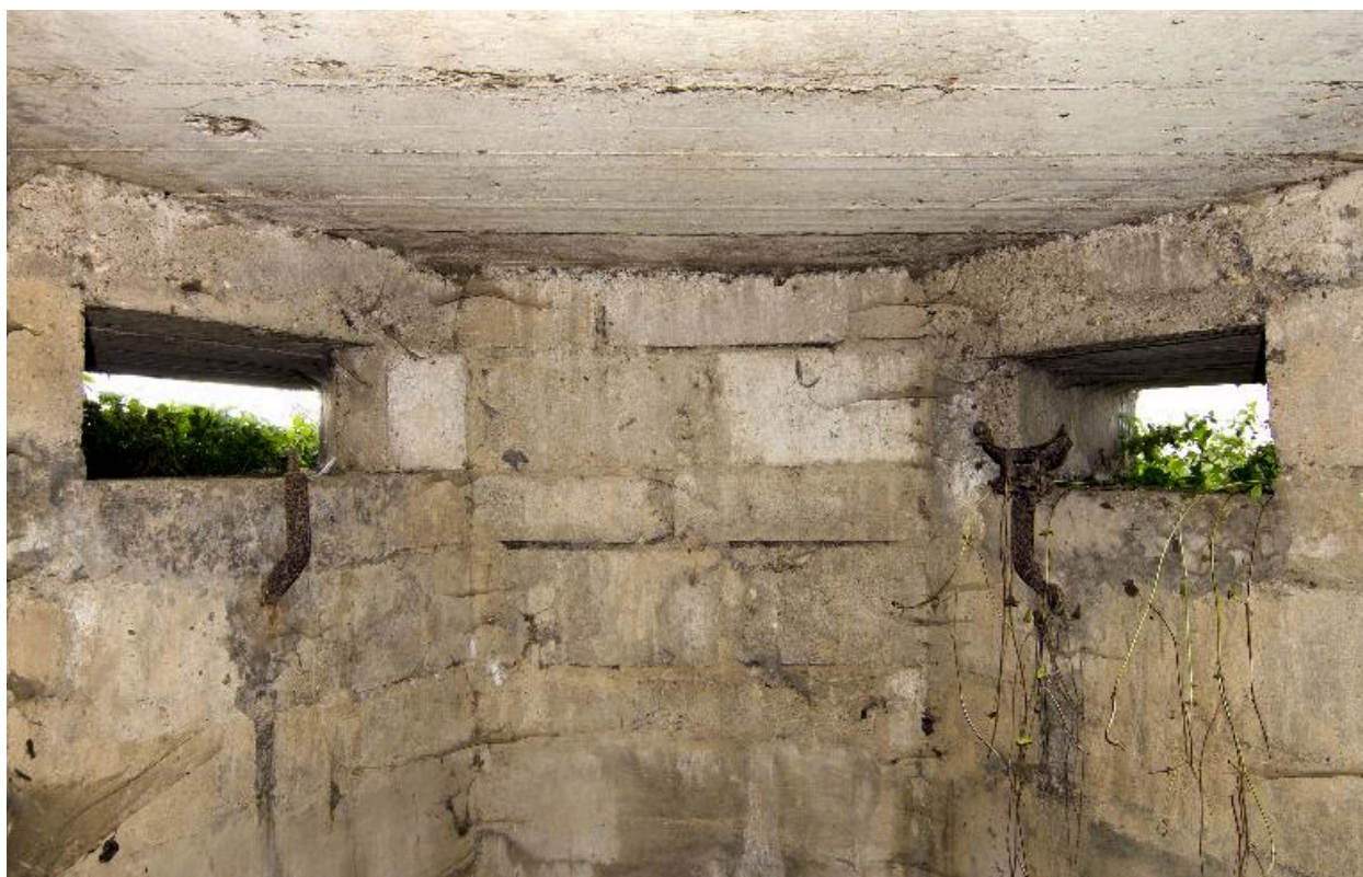
Vue intérieure de la tourelle sud
