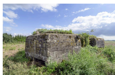
Vue de trois-quarts vers le sud-est Phot. Jean-Marc Ramette IVR31_20145905121NUCA
