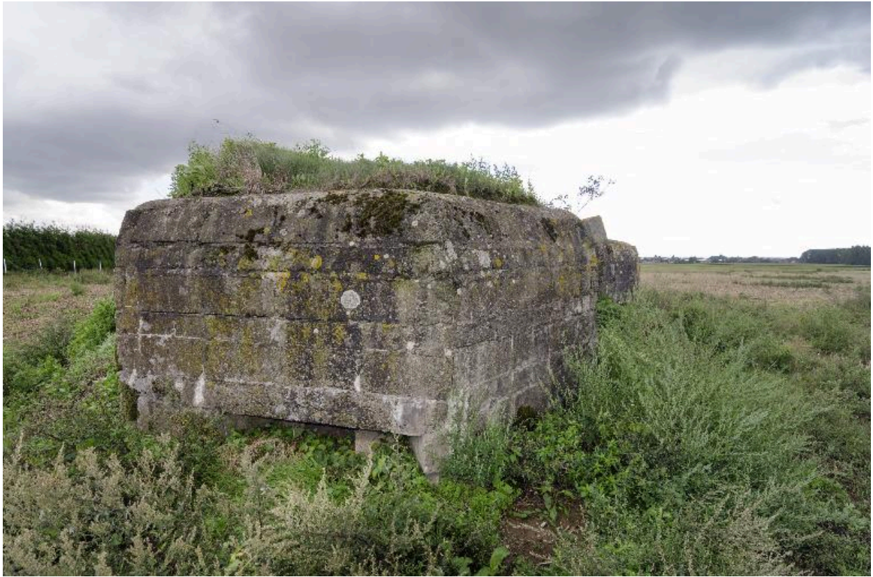
Tourelle nord, vers le sud-est
