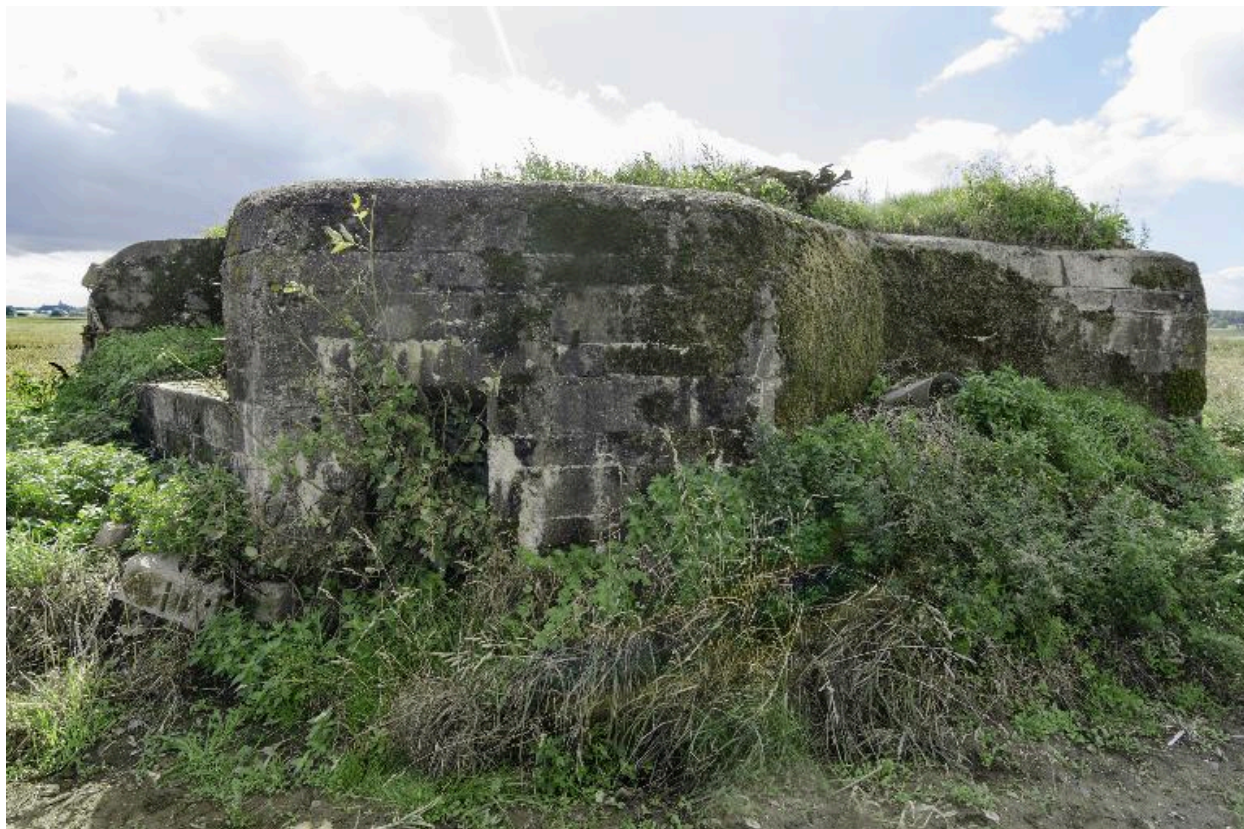
Vue de trois-quarts vers le sud-ouest. Entrée nord-est
