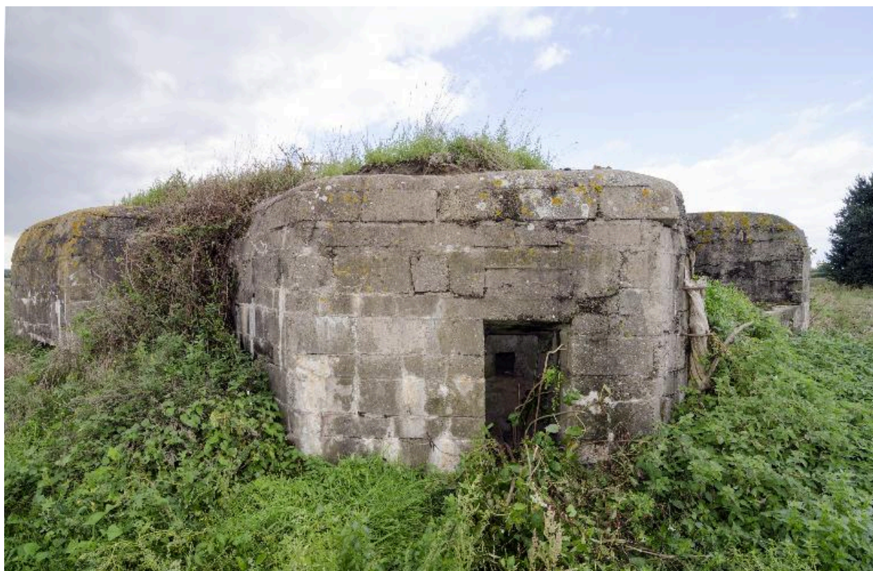
Vue de trois-quarts, vers nord-ouest. Entrée sud-est
