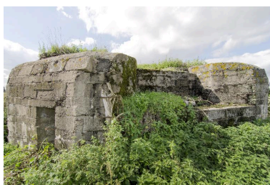
Vue de trois-quarts vers le nord-ouest. L'entrée sud-est, à gauche, la banquette de tir à droite Phot. Jean-Marc Ramette IVR31_20145905111NUCA
