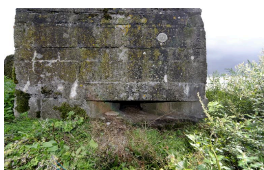
Embrasure de tir de la tourelle nord Phot. Jean-Marc Ramette IVR31_20145905102NUCA
