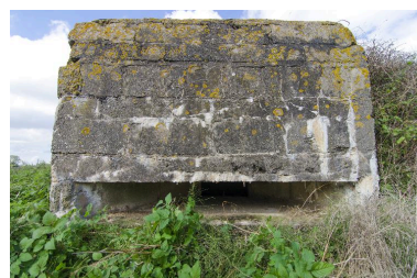
Embrasure de tir de la tourelle sud, vers le nord-ouest Phot. Jean-Marc Ramette IVR31_20145905108NUCA
