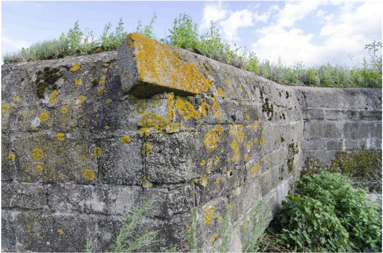
Pierre angulaire saillante sur la tourelle nord, probablement une des fixations de la bâche de camouflage
