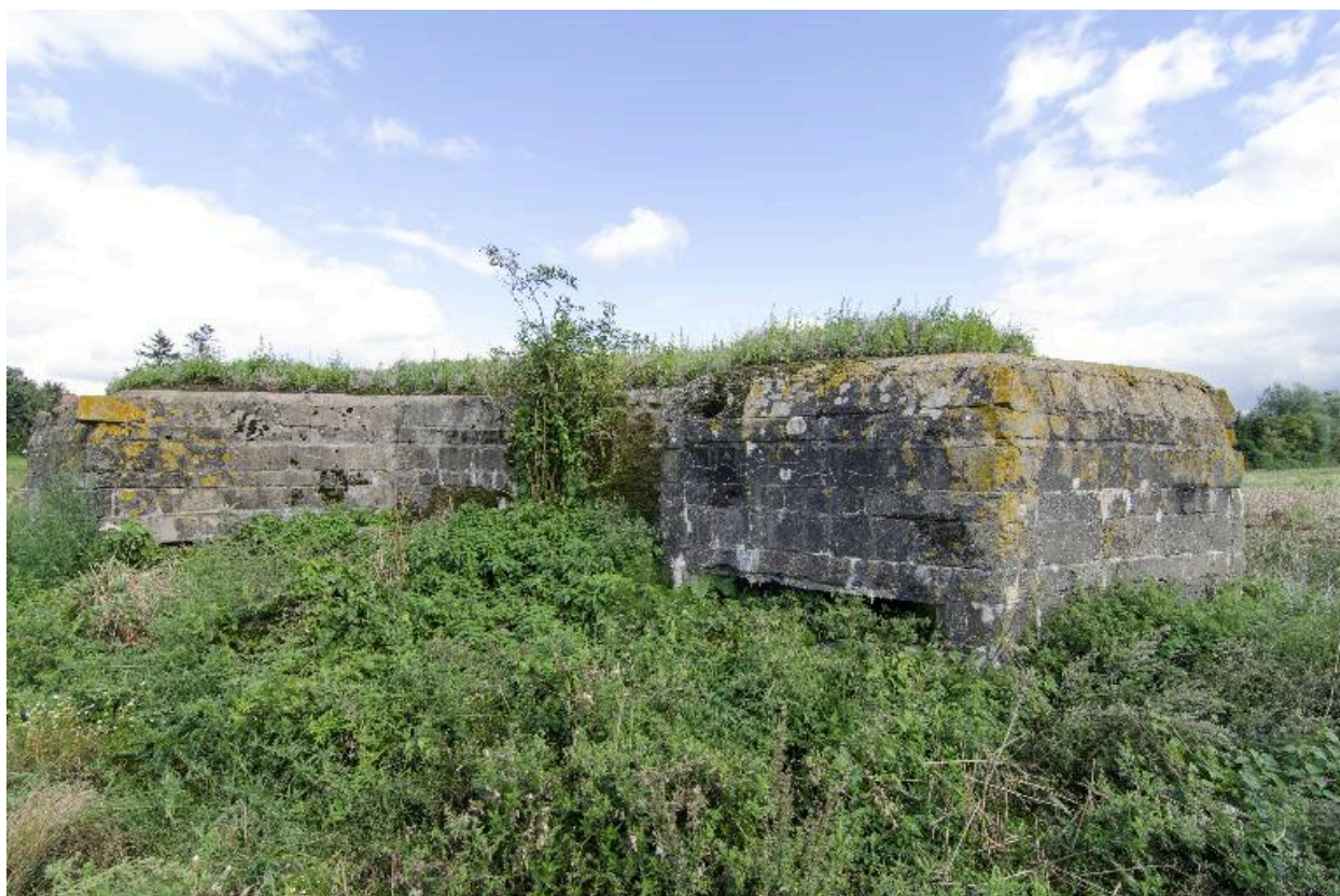
Vue de trois-quarts vers le nord-est
