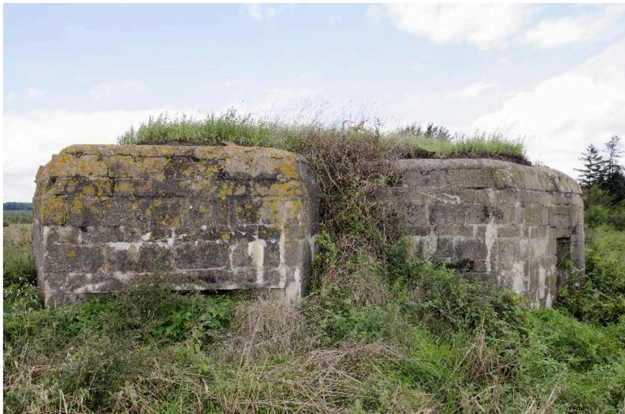
Vue latérale, vers le nord-ouest. A gauche, la tourelle sud. A droite l'entrée sud-est
