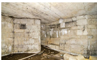
Vue intérieure de la salle sud vers le couloir en chicane de l'entrée sud-est Phot. Jean-Marc Ramette IVR31_20145905089NUCA
