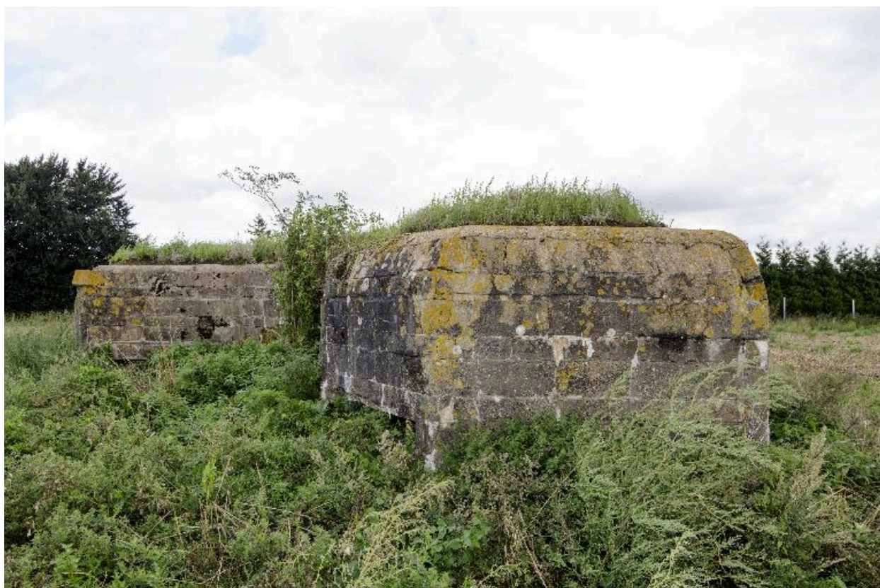
Vue vers le nord. A gauche la tourelle sud. A droite, la tourelle nord
