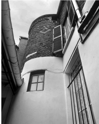
Vue extérieure de l'escalier demi-hors-oeuvre. Phot. Franck Bürjes IVR22_19990207284X
