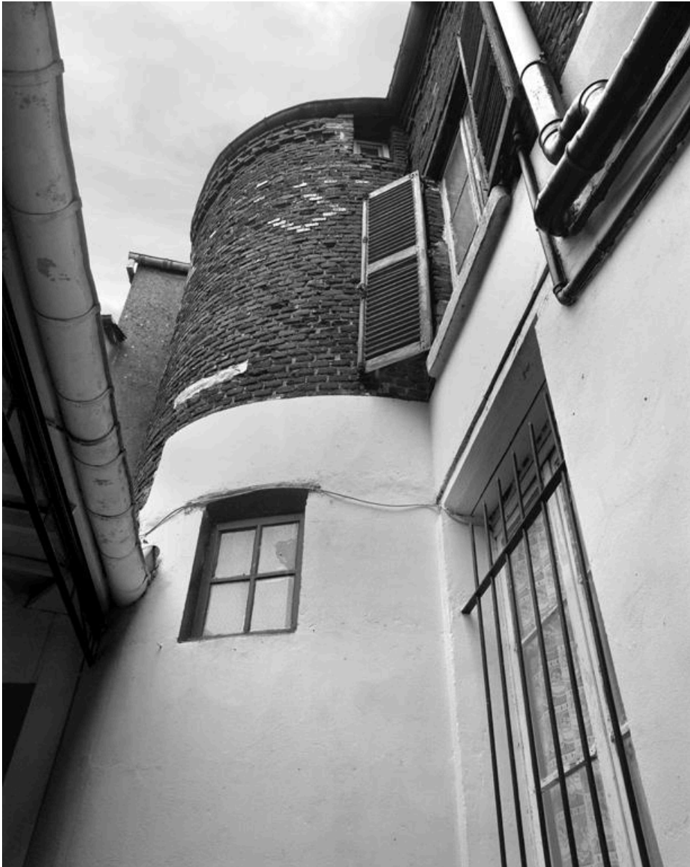
Vue extérieure de l'escalier demi-hors-oeuvre.
