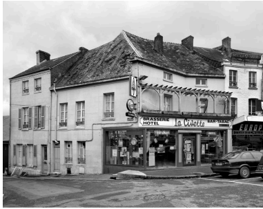
Vue des élévations sur rue. Phot. Franck Bürjes IVR22_19990207275V
