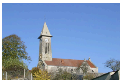
Vue méridionale. Phot. Inès Guérin IVR22_20030202103NUCA
