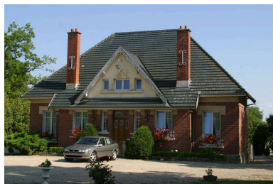
Vue sur cour du logement du gardien. Phot. Irwin Leullier IVR22_20050200852NUCA
