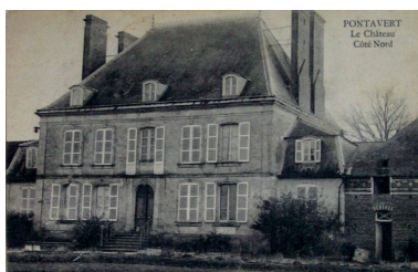
Elévation postérieure du manoir, avant 1917 (coll. part). Phot. Inès Guérin IVR22_20030202980NUCAB
