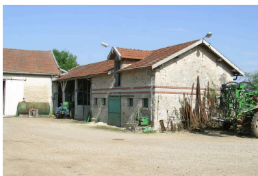
Bâtiment annexe. Phot. Irwin Leullier IVR22_20050200855NUCA
