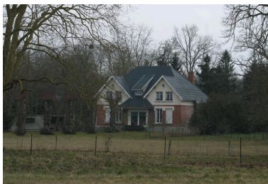
Vue postérieure du logement du gardien. Phot. Irwin Leullier IVR22_20050200655NUCA
