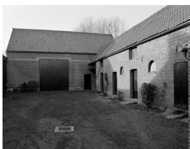
Vue générale de la cour : étables-écuries et grange. Phot. Philippe Dapvril IVR31_20055900006X
