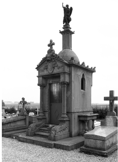
Vue d'ensemble. Phot. Thierry Lefébure IVR22_19920201269Z
