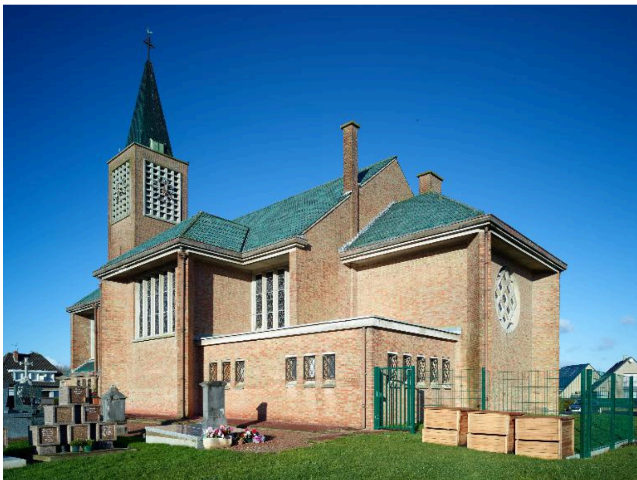
Vue de trois quart arrière, côté droit.
