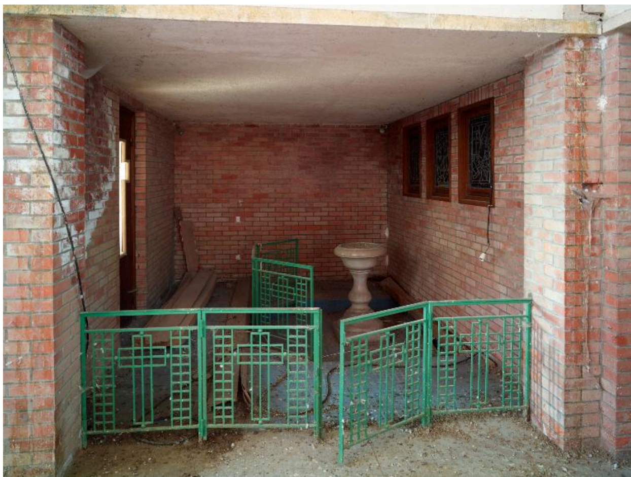
Vue de la chapelle des fonts baptismaux
