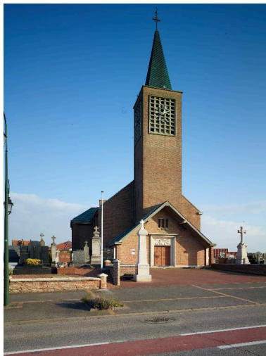
élévation antérieure de trois quart gauche Phot. Pierre Thibaut IVR31_20155902099NUCA
