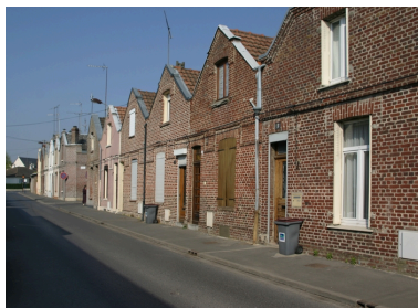
Les logements ouvriers construits vers 1885, rue Pierre de Corbie (au centre, l'impasse du même nom). Phot. Frédéric Pillet IVR22_20070205188NUCA
