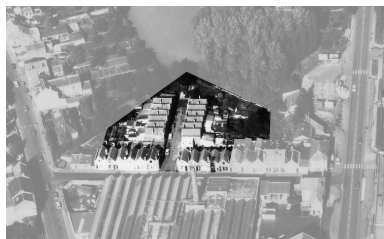
Vue aérienne de la cité en 1989. Phot. Pillet Frédéric, Autr. Phot'R IVR22_20060205715NUCA
