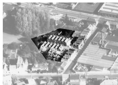
Vue aérienne de la cité en 1989. Phot. Pillet Frédéric, Autr. Phot'R IVR22_20060205714NUCA
