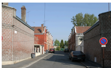
Logements ouvriers construits en 1922 dans l'impasse Pierre de Corbie. Phot. Frédéric Pillet IVR22_20070205190NUCA
