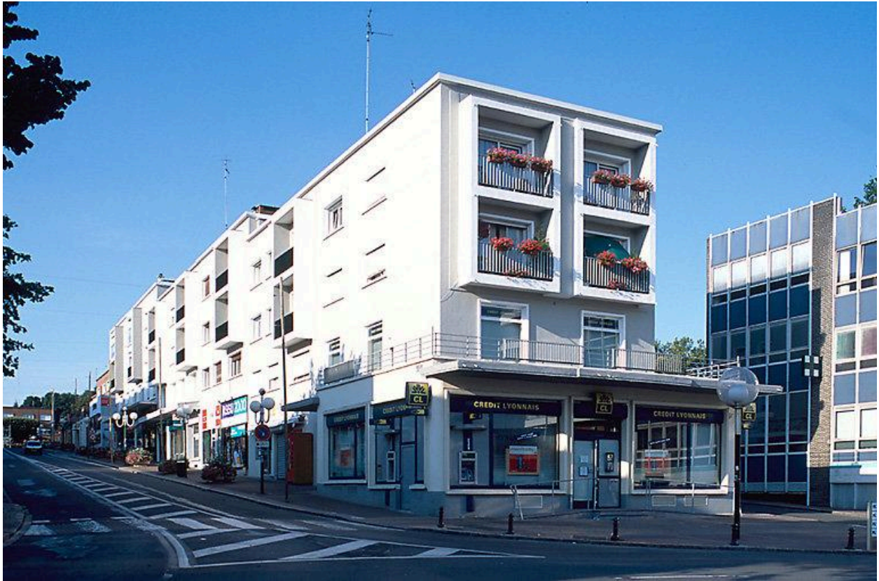
Vue générale de l'alignement est.
