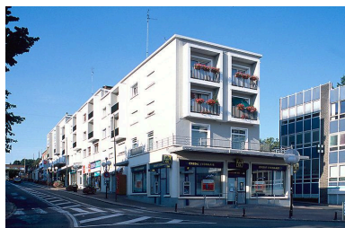
Vue générale de l'alignement est. Phot. Thierry Petitberghien IVR31_20025902146ZA
