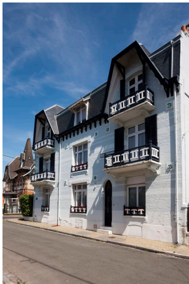
Élévation sur la rue Armand. Phot. Hubert Bouvet IVR31_20136200143NUCA
