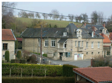
Vue générale. Phot. Inès Guérin IVR22_20030202889NUCA
