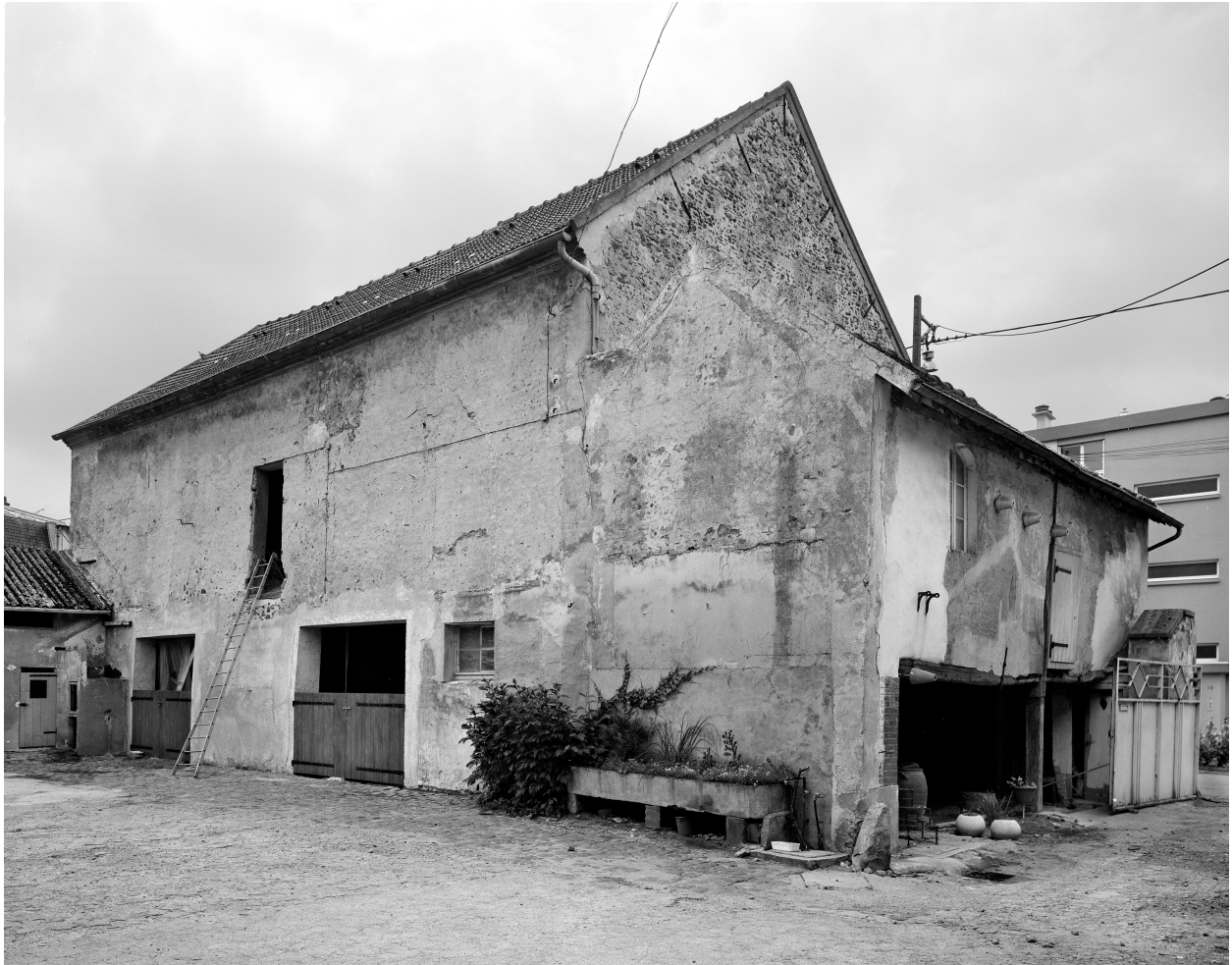
Vue de la grange, ancienne étable.
