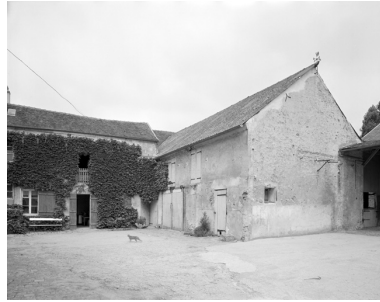
Vue du bâtiment d'habitation et d'un commun. Phot. Thierry Lefébure IVR22_19960200503V
