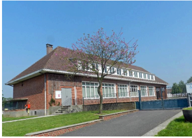
Vue générale depuis la place de la Mairie. Phot. Romain Grimaud IVR22_20138015970NUC1A
