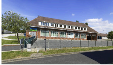
Vue générale. Phot. Thierry Lefébure IVR22_20158000583NUC2AQ
