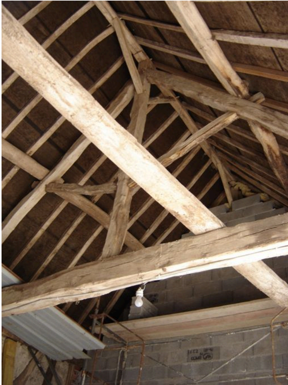
Vue détaillée de la charpente.
