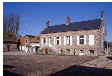
Vue du logis et de l'écurie augmentée de l'étable. Phot. Irwin Leullier IVR22_20078000079XA
