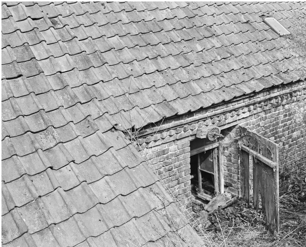
Ouverture sur le bâtiment d'eau.
