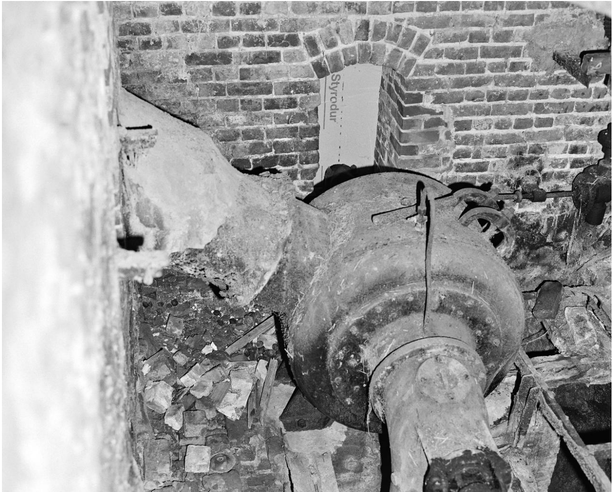
Turbine hydraulique (état de 1993).
