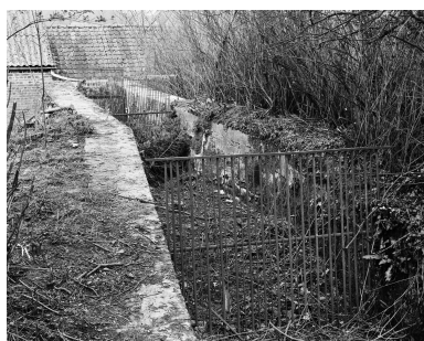
Ancien bief. Phot. Olivier Marlard IVR31_19936200463X
