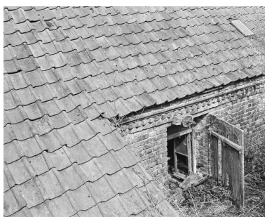
Ouverture sur le bâtiment d'eau. Phot. Olivier Marlard IVR31_19936200462X
