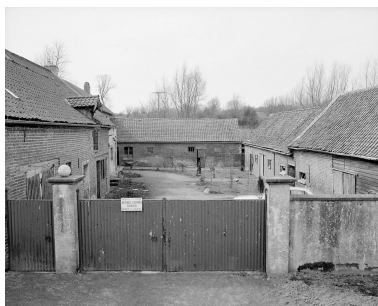
Vue depuis l'est, élévation sur cour, à gauche atelier de fabrication. Phot. Olivier Marlard IVR31_19936200465X
