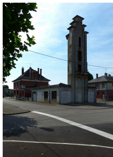
Vue de la remise et de la tour, depuis le nord. Phot. Isabelle Barbedor IVR32_20170205616NUCA
