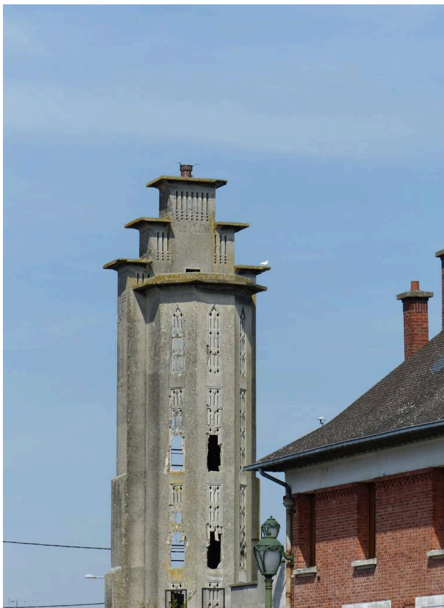
Vue de la partie supérieure de la tour et du réseau ajouré.
