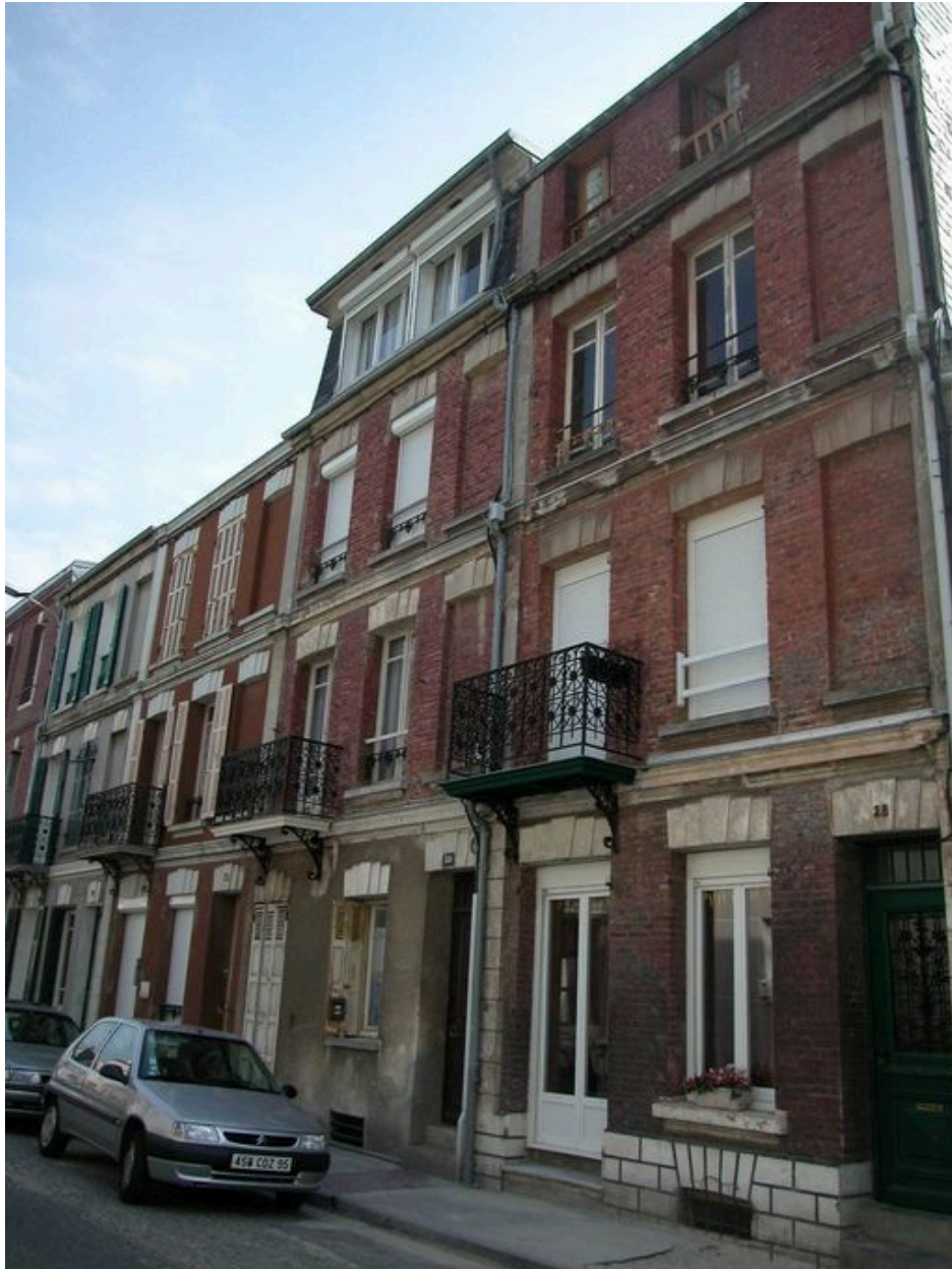
Vue d'ensemble des quatre logements.
