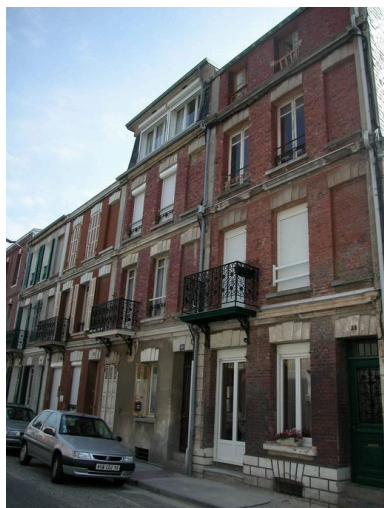
Vue d'ensemble des quatre logements.
