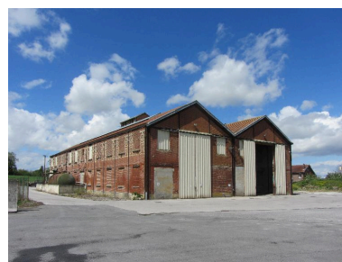
Vue d'ensemble de la façade sud-est de l'atelier principal de la râperie. Phot. Bertrand Fournier IVR22_20158005975NUCA
