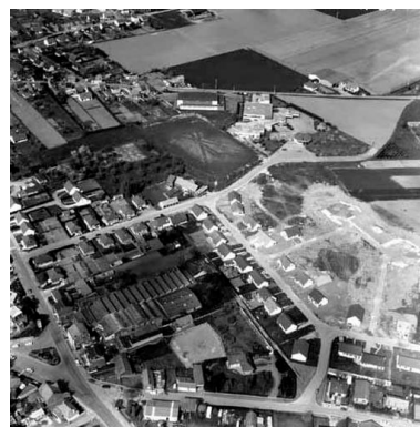
Vue aérienne de l'usine, avec silos.
