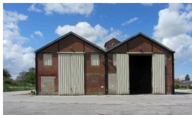
Façade est de la râperie. Phot. Bertrand Fournier IVR22_20158005977NUCA
