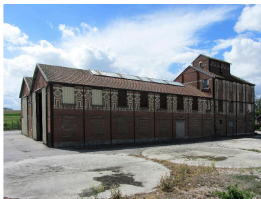
Vue d'ensemble de la façade nord de la râperie. Phot. Bertrand Fournier IVR22_20158005978NUCA
