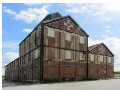
Vue d'ensemble nord-ouest de la râperie. Phot. Bertrand Fournier
