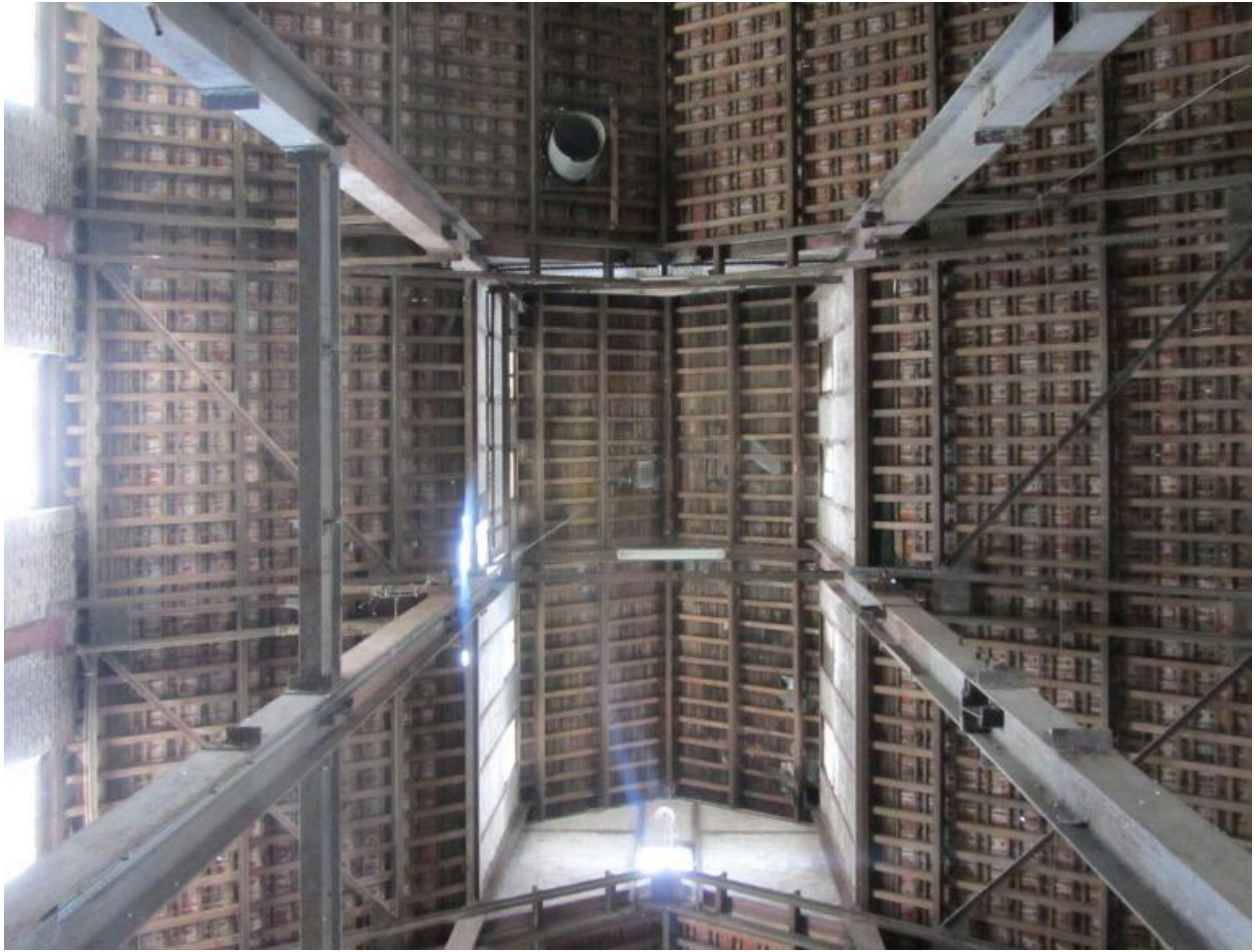
Vue intérieure de la charpente métallique de l'atelier principal de la râperie.
