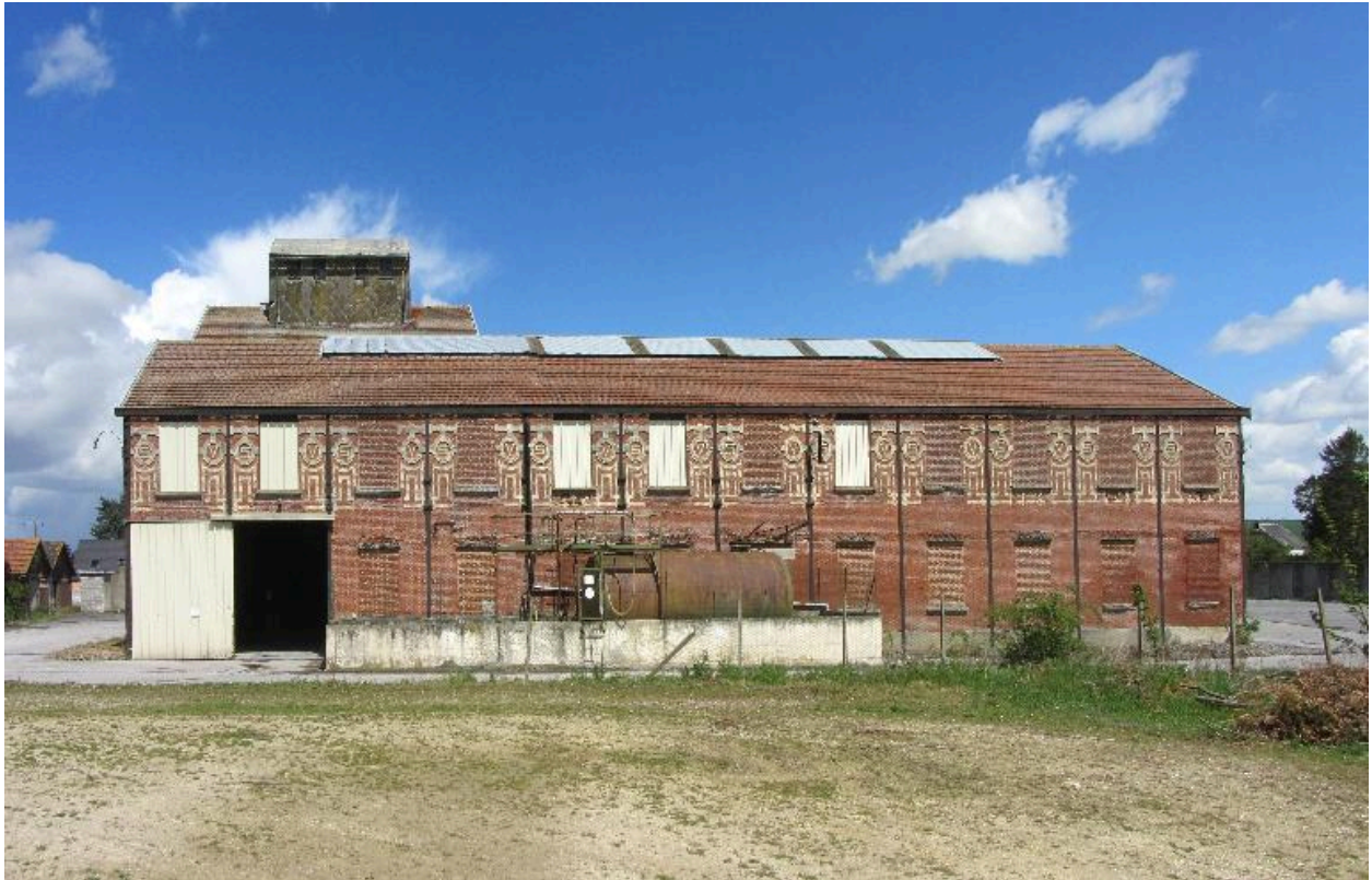
Vue d'ensemble de la façade longitudinale sud de la râperie.
