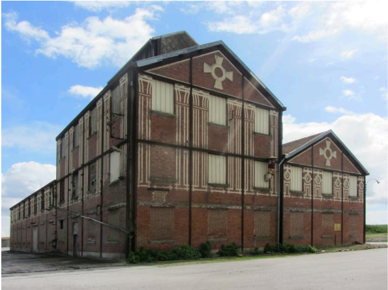
Vue d'ensemble nord-ouest de la râperie.
