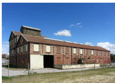
Vue d'ensemble sud-ouest de le l'atelier principal de la râperie. Phot. Bertrand Fournier IVR22_20158005969NUCA
