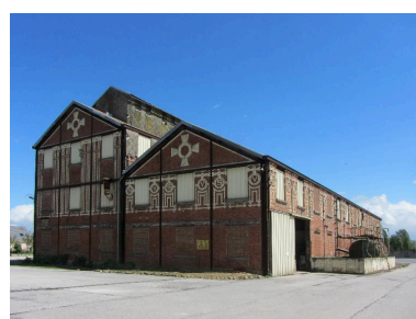
Vue d'ensemble de la façade ouest de la râperie.
