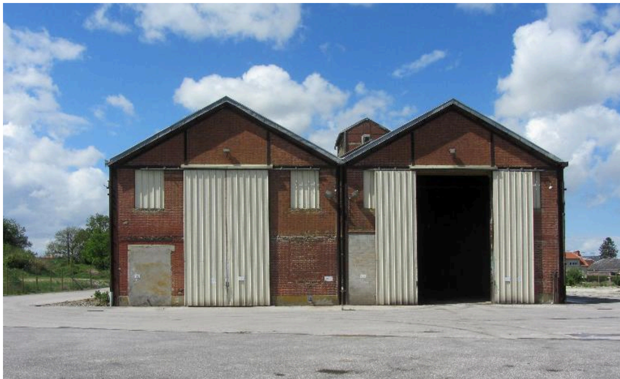
Façade est de la râperie.
